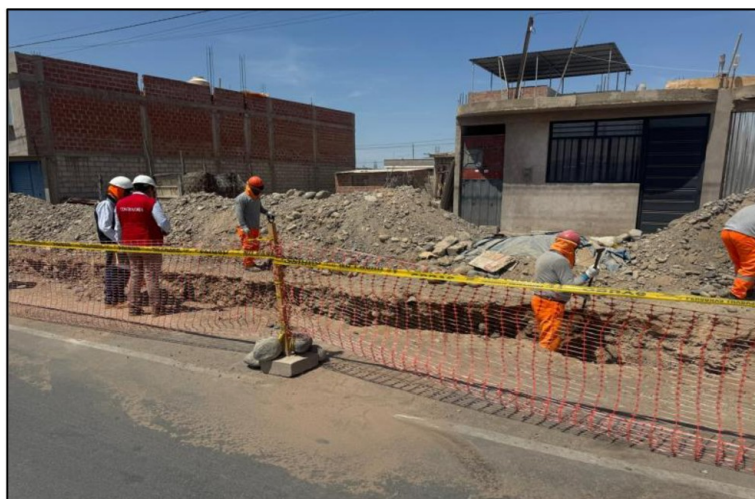
Imágenes N°s 2, 3 y 4 Verificación de trabajos de relleno manual en la Av. La Marina
