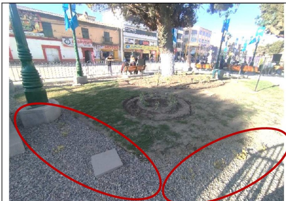
Fotografía n.º 9: Área destinada al cerco vivo con vegetación marchita.
