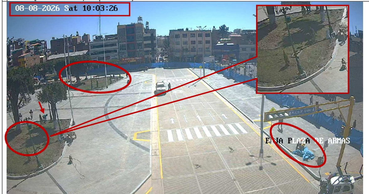
Imagen n.º 6: Captura de pantalla del video de la cámara de seguridad fija, del 8 de agosto de 2026, en la cual se advierte al lado izquierdo la falta del sembrado de árboles (partida 01.03.01.07.04) y sembrado de vegetación ornamental (partida 01.03.01.07.06) y la presencia de personal efectuando trabajos dentro de las áreas verdes; además, al lado derecho se visualiza la ejecución de trabajos de pintura amarilla (pintura en sardinel, partida 02.04.01.01).
