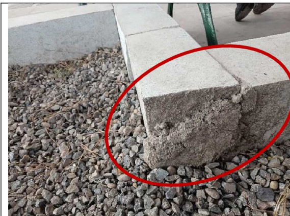
Fotografía n.º 17: Concreto sólido en sardinel de áreas verdes.
