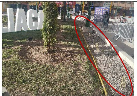
Fotografía n.º 10: Área destinada al cerco vivo con vegetación marchita.
