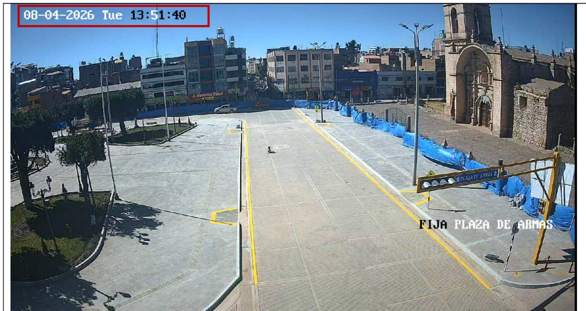
Imagen n.º 5: Captura de pantalla del video de la cámara de seguridad fija, del 4 de agosto de 2026, en la cual se advierte la falta de pintura en pavimento (partida 02.04.01.01) en el jirón Salaverry.
