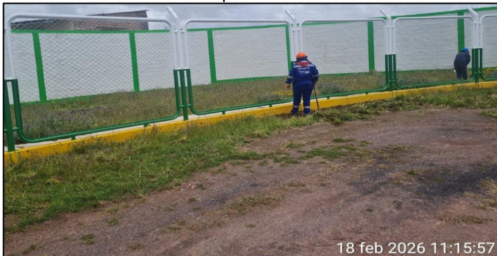
Imagen n.º 4 Limpieza de la obra
