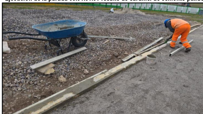
Imagen n.º 17 Ejecución de la partida 03.01.01.01 resane de sardinel de cemento pulido
