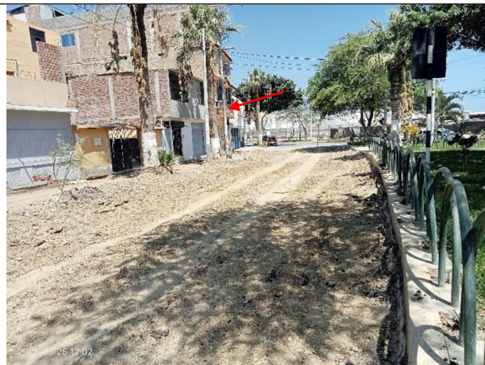
Poste de alumbrado público a reubicar.
