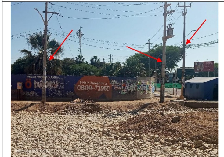
Postes de media tensión a reubicar.
