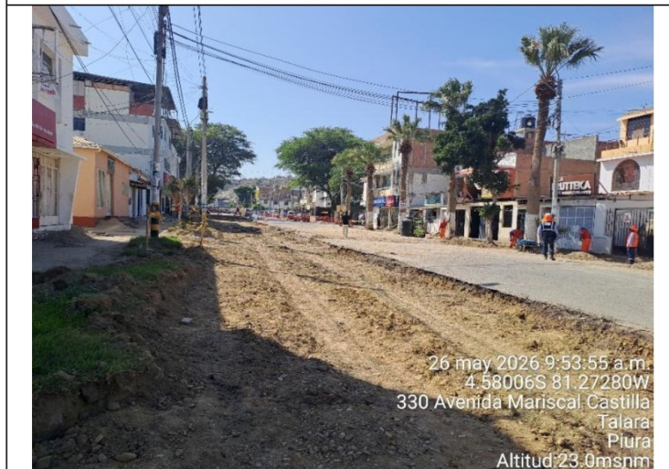
Conformación de subrasante – Av. D (área de estacionamientos).
