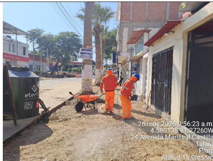
Nivelación en área de veredas – Av. D.
