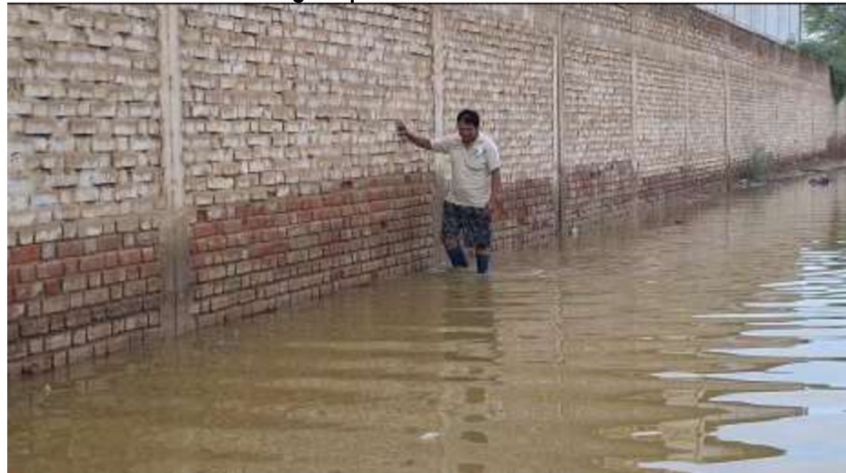
Acumulación de aguas pluviales en el Sector 13 de Noviembre
