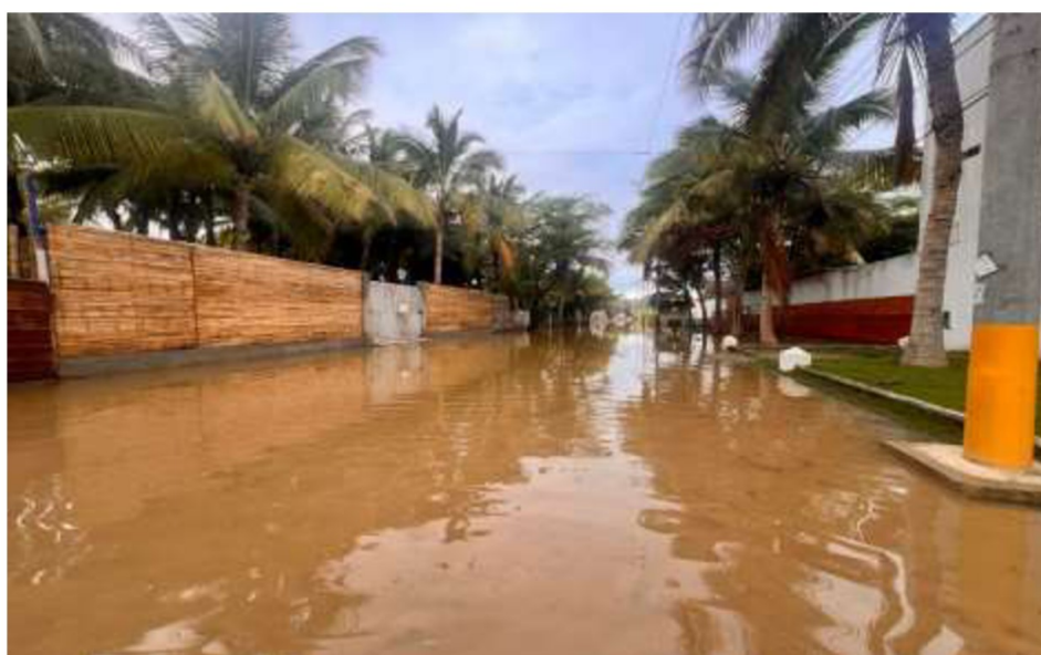
Imagen n.º 6 Acumulación de aguas pluviales en Calle Spondylus – Los Cocales
