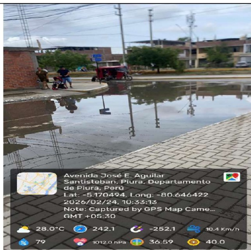
Fotografía n.º 5.- Se observó acumulación de aguas pluviales en una de las esquinas, afectando directamente a un predio colindante.
