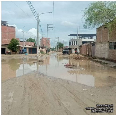
Fotografía n.º 7.- Se observa que la acumulación de agua dificulta el cruce entre manzanas.
