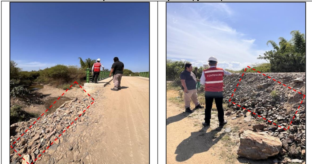
Fotografías n.º 5 y 6. Terraplenes de acceso al puente (eje A – 1)
