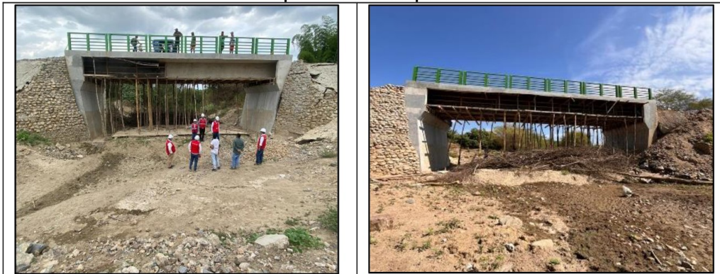
Fotografías n.º 1 y 2: Durante la visita de obra, se observó que en el puente se han ejecutado los trabajos de vaciado de concreto y aún continúa encofrado.
