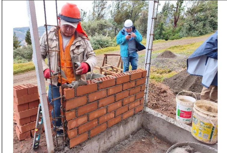
Asentado de ladrillos en muro de caseta de UBS.
