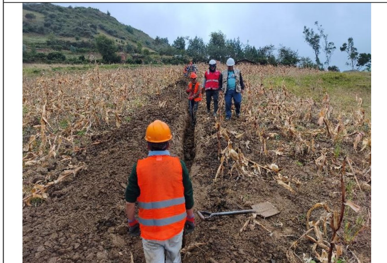
Excavación manual de zanja en red de distribución.
