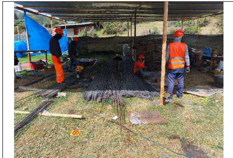
Habilitación de acero de refuerzo para estructuras del proyecto.
