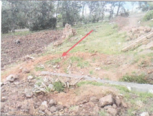
Construcción de zanja de percolación.
