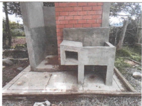
Construcción de lavadero (tarrajear).
