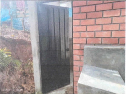
Instalación de puerta metálica en UBS.
