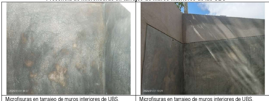
Panel fotográfico n.º 4 Presencia de microfisuras en tarrajeo de muros interiores de las UBS
