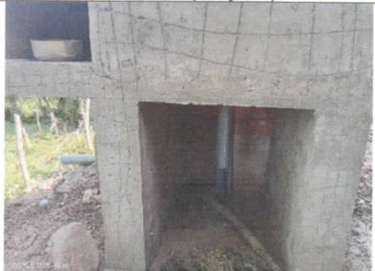
Instalación de tubería PVC debajo de lavadero.
