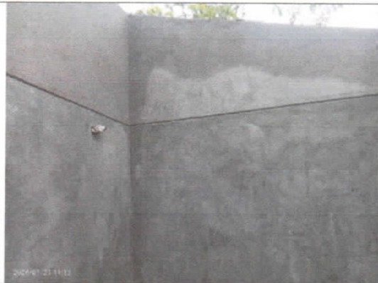
Deficiencias en la superficie del tarrajeo interior de UBS.
