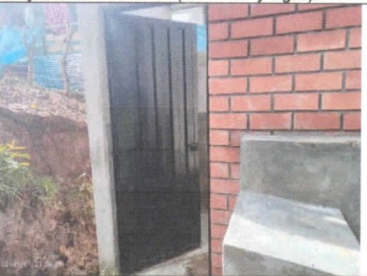
Instalación de puerta metálica en UBS.
