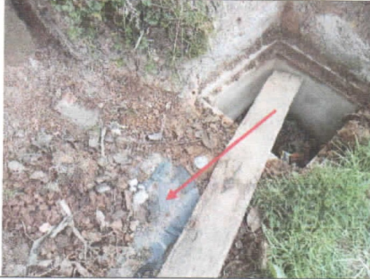
Instalación de biodigestor.
