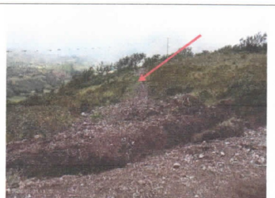
Relleno de zanja con material propio en red de distribución.
