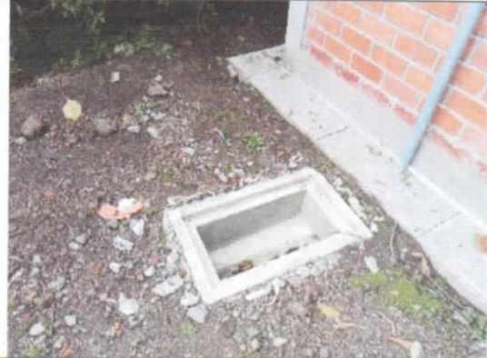
Construcción de caja de concreto.
