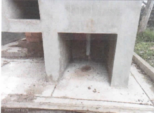
Instalación de tubería PVC debajo de lavadero.
