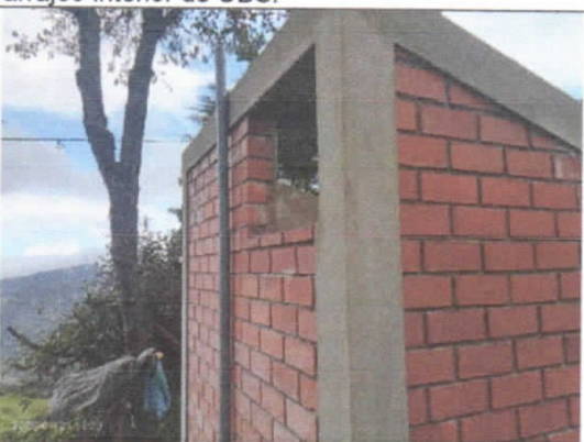
Tarrajeo exterior de UBS (columnas y vigas).
