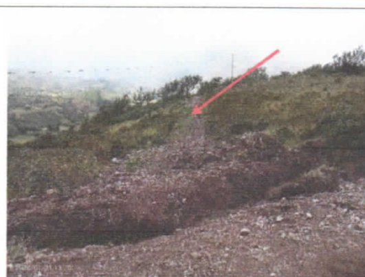
Relleno de zanja con material propio en red de distribución.
