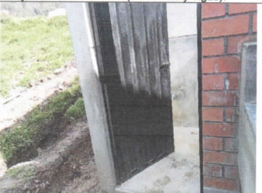
Instalación de puerta metálica en UBS.
