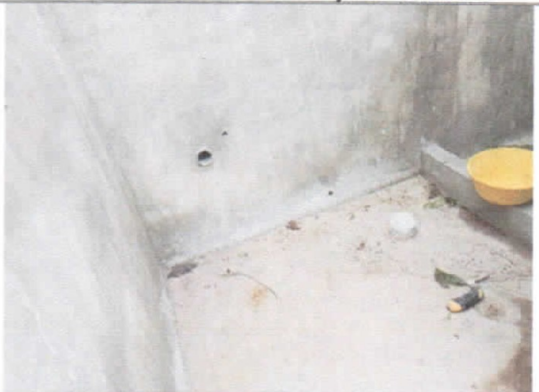
Instalaciones sanitarias en interior de UBS.
