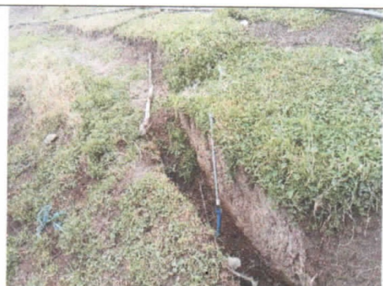
Colocación de tubería HDPE en red de distribución.
