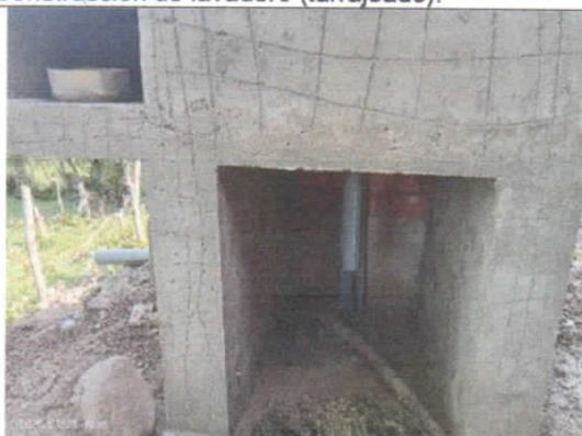
Instalación de tubería PVC debajo de lavadero.
