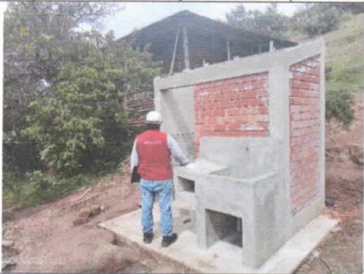
Tarrajeo exterior de UBS (columnas y vigas).
