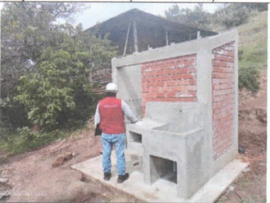
Tarrajeo exterior de UBS (columnas y vigas).
