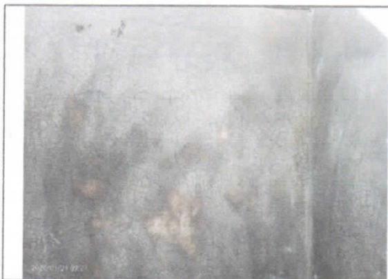
Deficiencias en la superficie del tarrajeo interior de UBS.
