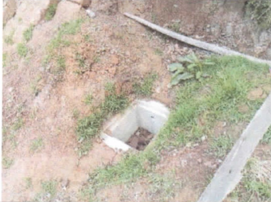
Construcción de caja de concreto.
