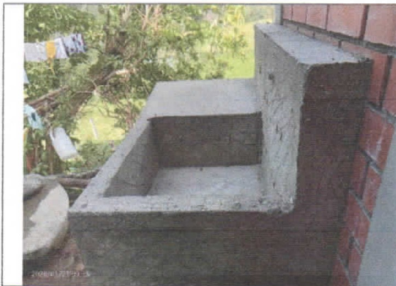
Construcción de lavadero (sin tarrajear).
