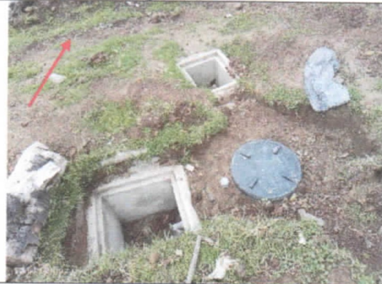
Construcción de zanja de percolación.
