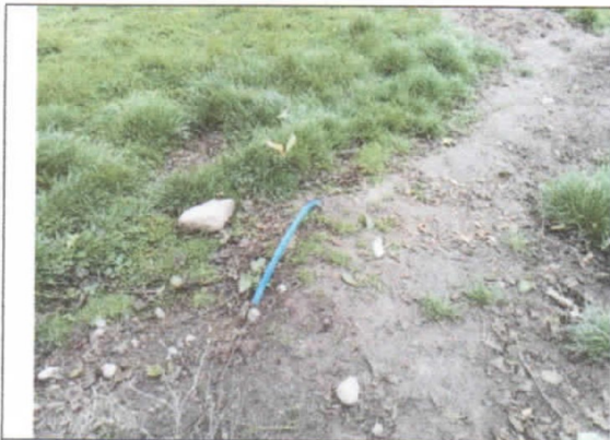
Colocación de tubería HDPE en red de distribución.
