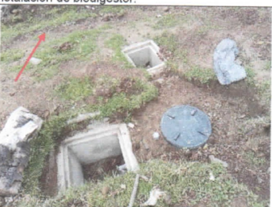
Construcción de zanja de percolación.
