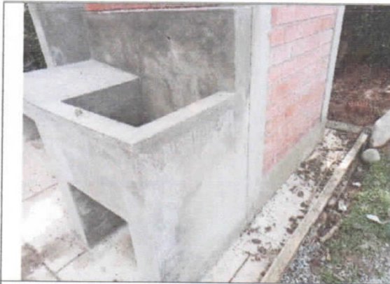
Construcción de veredas en exterior de UBS.
