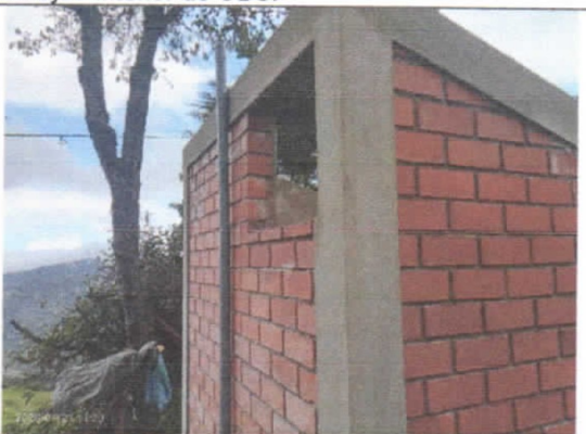
Tarrajeo exterior de UBS (columnas y vigas).
