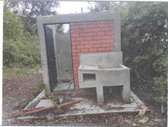
Construcción de veredas en exterior de UBS.
