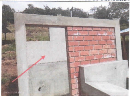
Tarrajeo interior de UBS.
