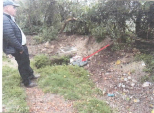
Instalación de biodigestor.
