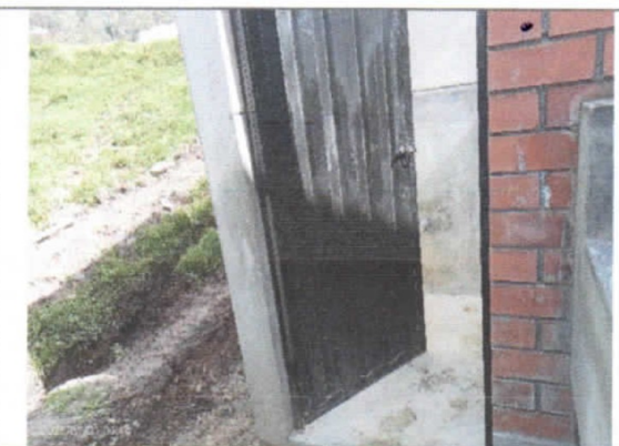
Puerta metálica que no abre por completo.
