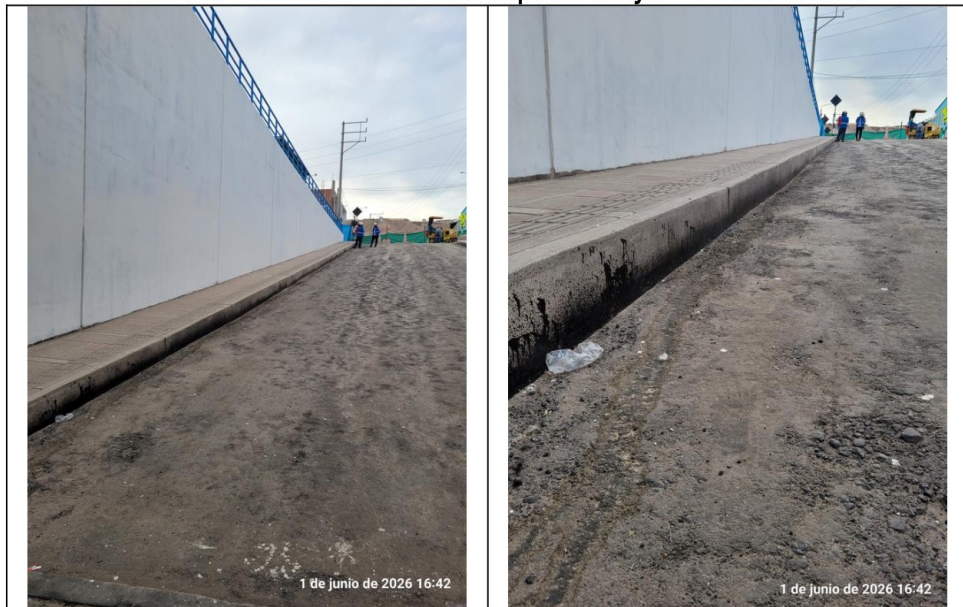
13. Se muestra deformación de base imprimada en área colindante a la vereda.
