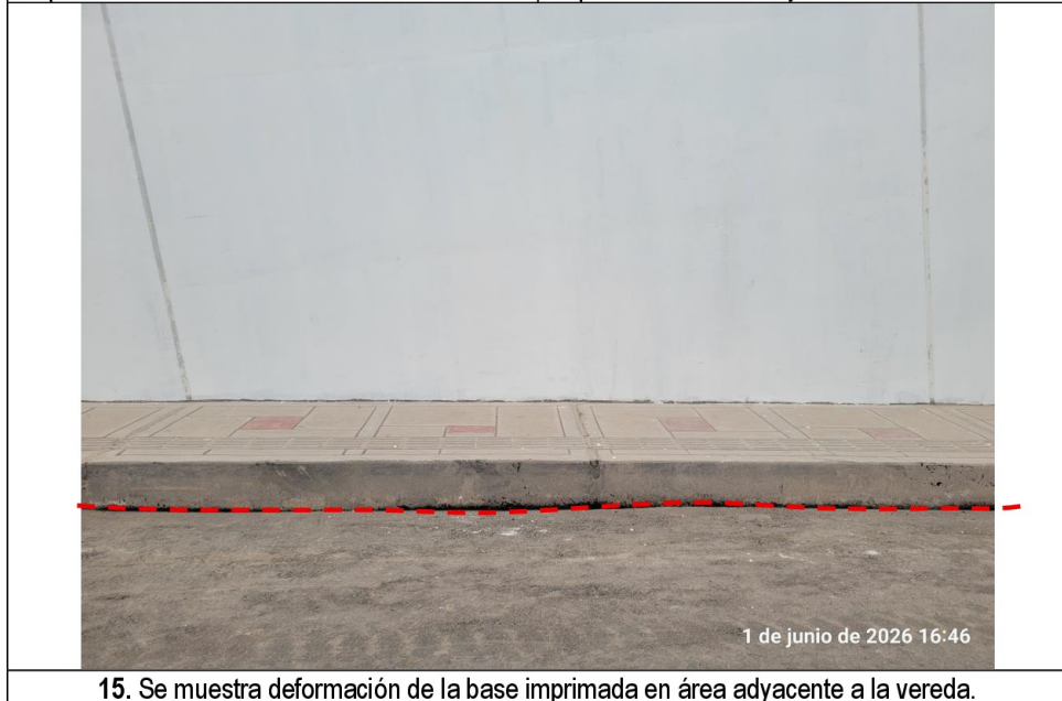
13. Se muestra deformación de base imprimada en área colindante a la vereda.
