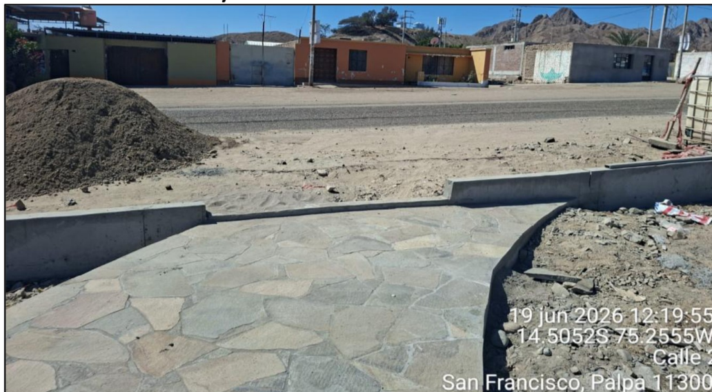
Imagen n.º 98 Ejecución de sardinel con discontinuidad
