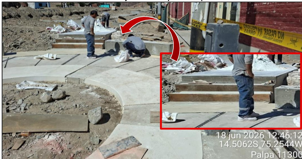
Imagen n.º 102 Construcción de escalera adyacente a rampa en el Espacio 1 de la Cuadra 4
