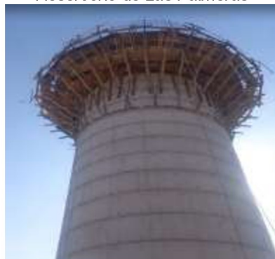
Imagen n.º 12 Reservorio de Las Palmeras
