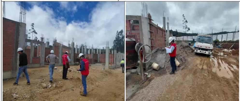
Ninguna evidencia de señalización o elementos de restricción a ciertas áreas que representan riesgo o peligro frente a posibles caídas (lado izquierdo excavación profunda con existencia de pozo de agua, lado derecho ausencia de señalización en zona de tránsito vehicular).
