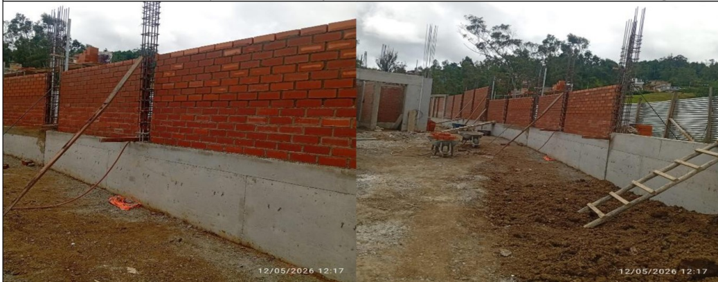
Asentado de ladrillo en paredes de cerco perimétrico en la parte posterior de los módulos del proyecto, a pesar que la obra esta suspendida.
