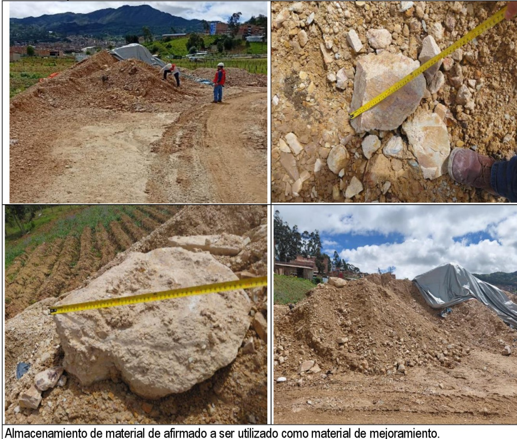
Almacenamiento de material de afirmado a ser utilizado como material de mejoramiento.
