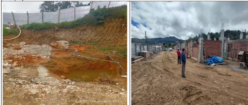
Ninguna evidencia de señalización o elementos de restricción a ciertas áreas que representan riesgo o peligro frente a posibles caídas (lado izquierdo excavación profunda con existencia de pozo de agua, lado derecho ausencia de señalización en zona de tránsito vehicular).
