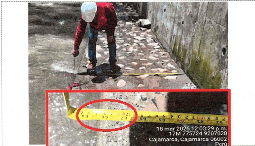
Fotografía n.º 13: En la coordenada UTM 775724 E y 9207828 N, se verificó el ancho de la construcción del mejoramiento con concreto ciclópeo de ancho de A= 1.73 m.
