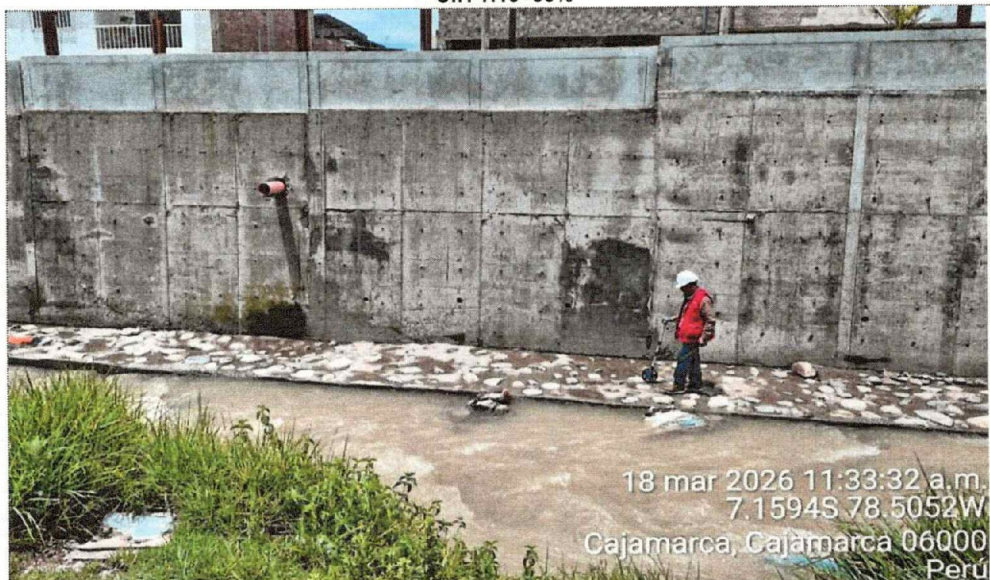
Fotografía n.º 4: Verificación de la longitud de la partida "Mejoramiento con concreto ciclópeo C:H 1:10+60% (Diámetro promedio de 0.80 m)", habiendo iniciado el recorrido en la progresiva 0+000, tomando como punto de partida Av. Vía de Evitamiento Sur (Puente amarillo).
