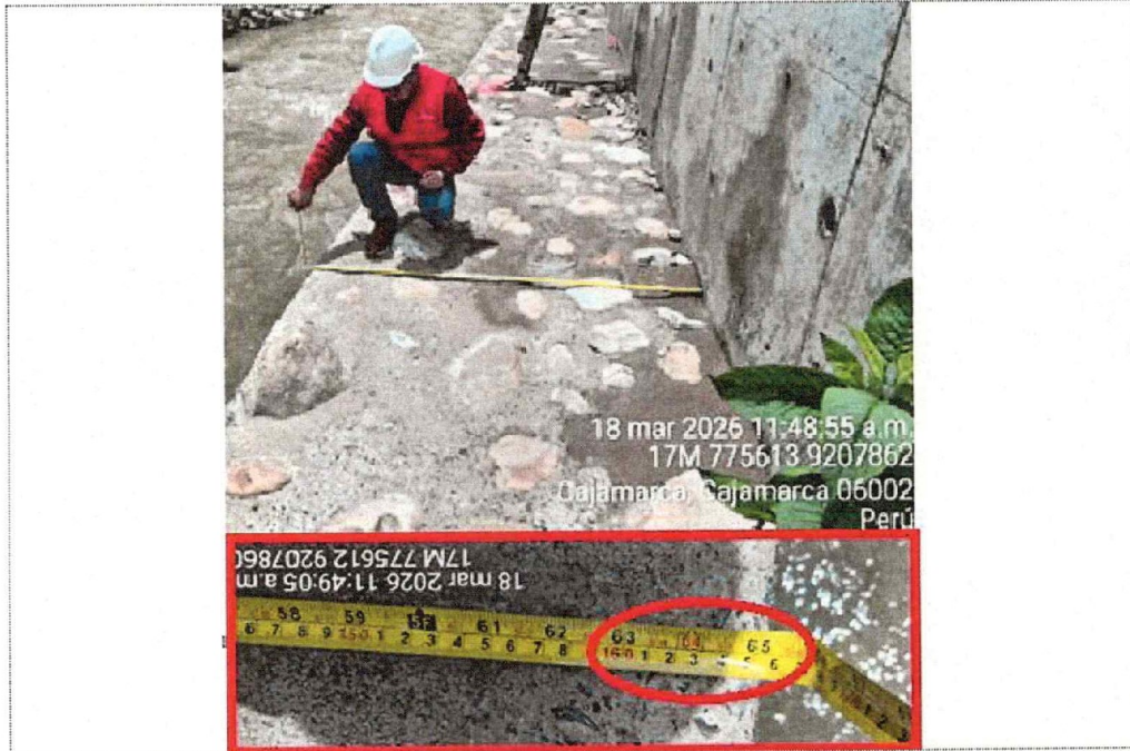
Fotografía n.º 9: En la coordenada UTM 775613 E y 9207862 N, se verificó el ancho de la construcción del mejoramiento con concreto ciclópeo de ancho A = 1.65 m.
