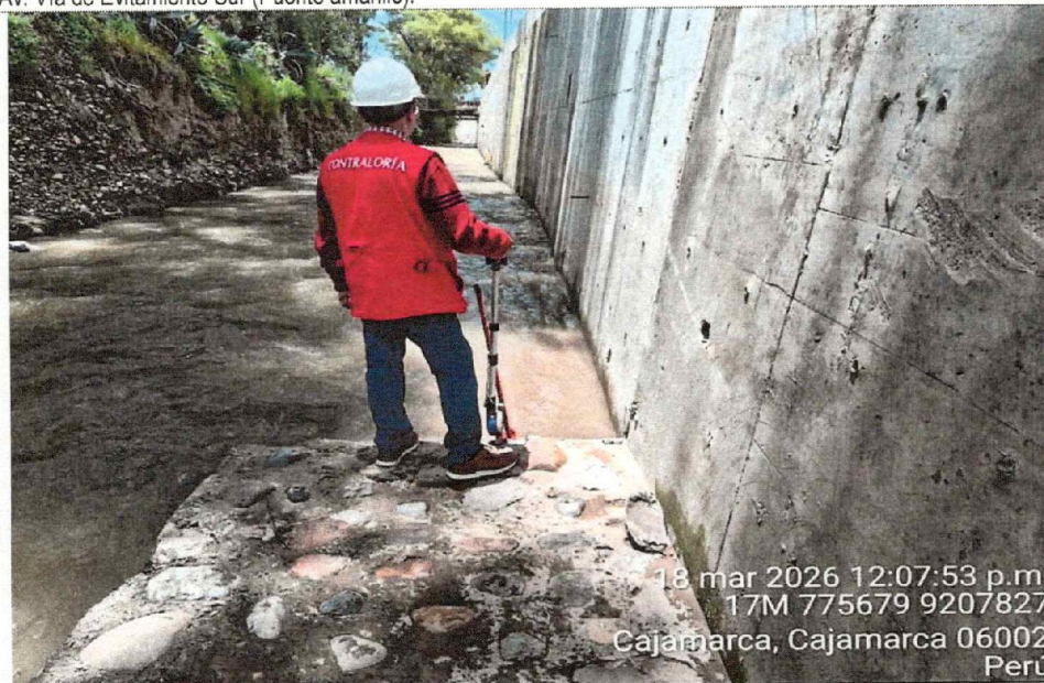
Fotografía n.º 5: Se verifica que hasta la progresiva 0+273.85 se puede visualizar la ejecución de la partida "Mejoramiento con concreto ciclópeo C:H 1:10+60% (Diámetro promedio de 0.80 m)".
