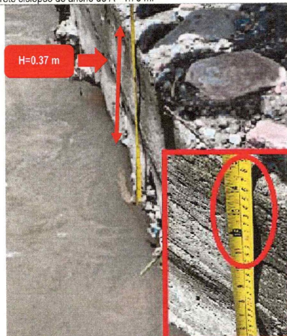
Fotografía n.º 14: En la coordenada UTM 775724 E y 9207828 N, se verificó la altura de la construcción del mejoramiento con concreto ciclópeo de altura de H= 0.37 m.
