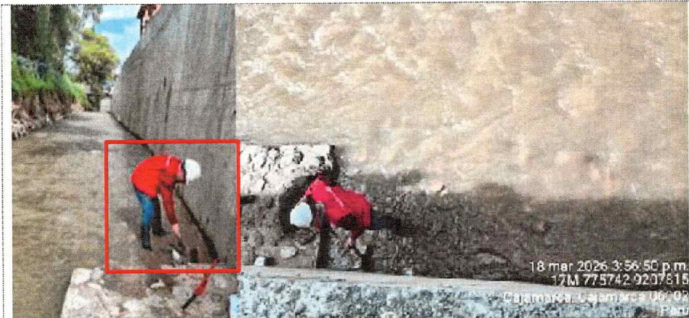
Fotografía n.º 6: Se verifica que hasta la progresiva 0+273.85 se puede visualizar la ejecución de la partida "Mejoramiento con concreto ciclópeo C:H 1:10+60% (Diámetro promedio de 0.80 m)", a continuación de la misma, se realizó una excavación, constatándose la no continuidad de la ejecución de la citada partida.
