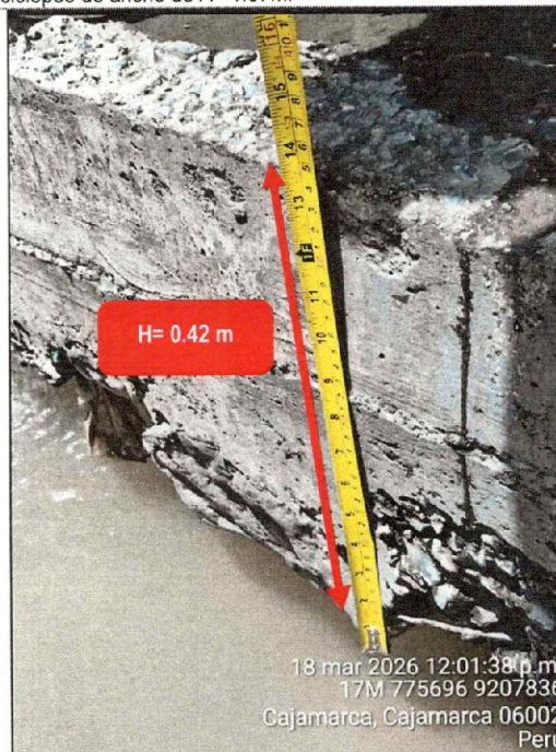
Fotografía n.º 16: En la coordenada UTM 775696 E y 9207836 N, se verificó la altura de la construcción del mejoramiento con concreto ciclópeo de altura de H = 0.42\text{m} .
