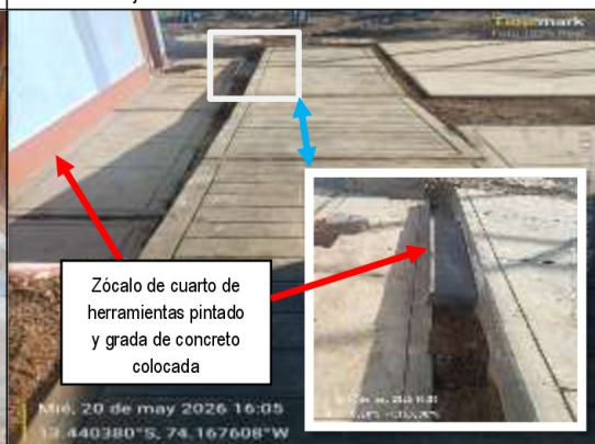
Imagen n.º 8: El 20 de mayo de 2026 se observa el pintado color ocre del zócalo del cuarto de herramientas del PTAP y desnivel con grada de concreto.
