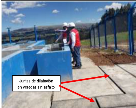
Imagen n.º 5: El 18 de mayo de 2026 se aprecia que las juntas aun no fueron selladas alrededor de la cámara de pre-filtro de la Planta de tratamiento de Agua Potable-PTAP.
