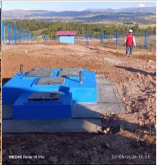
Imagen n.º 4: El 20 de mayo de 2026, se observa veredas de concreto en torno a la cámara distribuidora de caudales culminadas y todos los alrededores se encuentran limpios de material de corte.
