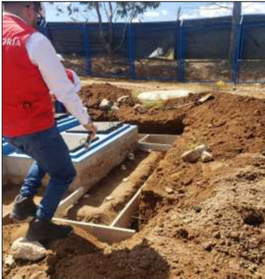
Imagen n.º 3: El 18 de mayo de 2026, se observa encofrado de veredas en torno a la cámara distribuidora de caudales de la PTAP; asimismo, se observa la colocación de material de corte a los lados de la cámara.
