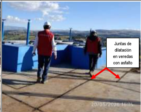
Imagen n.º 6: El 20 de mayo de 2026 se observa las veredas de concreto en torno a la cámara de pre-filtro del PTAP con juntas de dilatación selladas.
