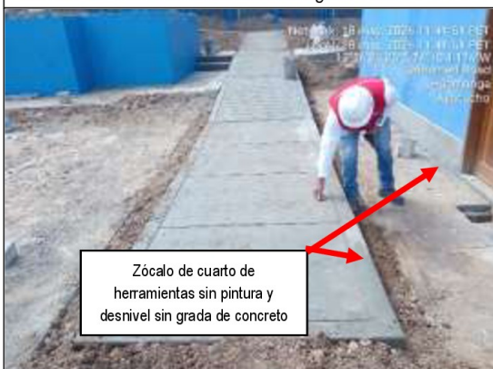
Imagen n.º 7: El 18 de mayo de 2026 se visualiza el zócalo del depósito de herramientas y arena del PTAP (expediente aprobado) sin pintura y sin pasos en desnivel,
