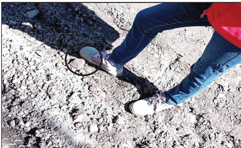
IMAGEN N° 1 MATERIAL COLOCADO EN CARRIL DE SUBIDA CON PARTÍCULAS DE TAMAÑO MAYOR A 2"
