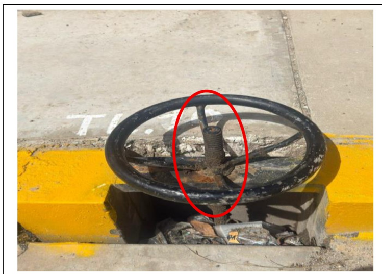
FOTOGRAFÍA N° 38 PRESENCIA DE OXIDACION EN COMPUERTA METÁLICA DE CANAL
