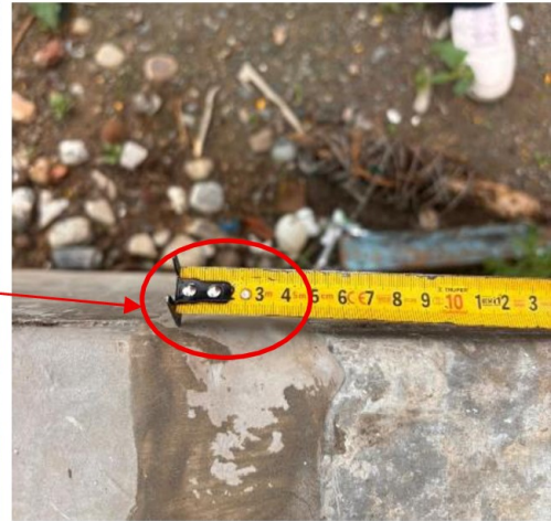
Fotografía n.º 11: Se observa que la junta de dilatación del muro de contención es de 4 cm.
