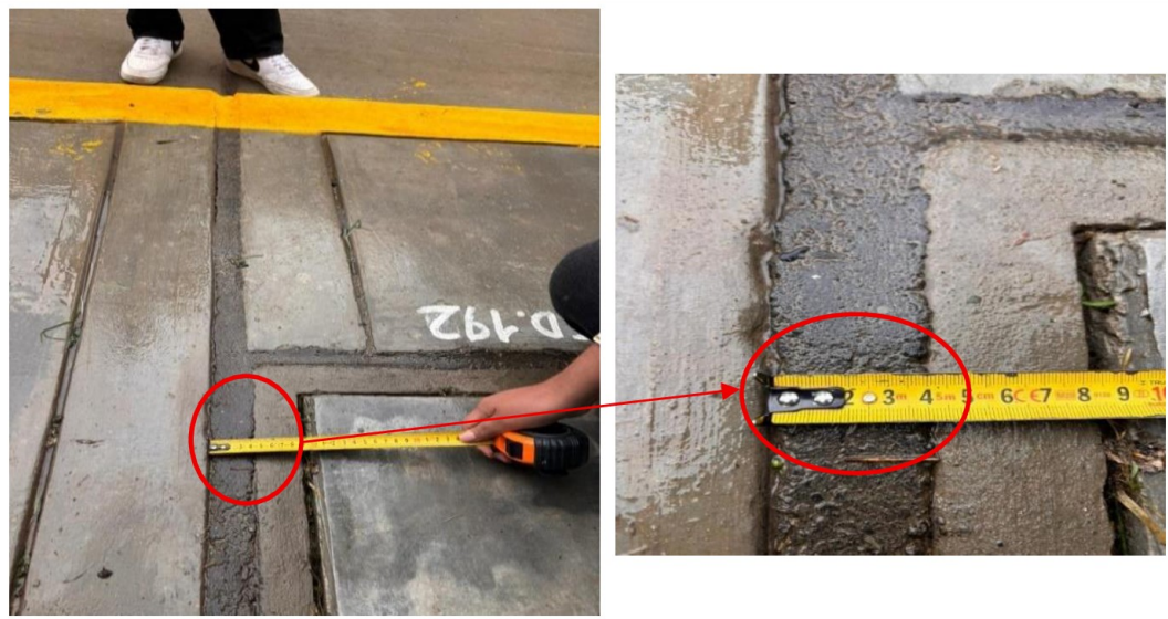
Fotografía n.º 10: Se observa que la junta asfáltica de la vereda es de 4 cm.
