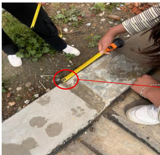
Fotografía n.º 11: Se observa que la junta de dilatación del muro de contención es de 4 cm.
