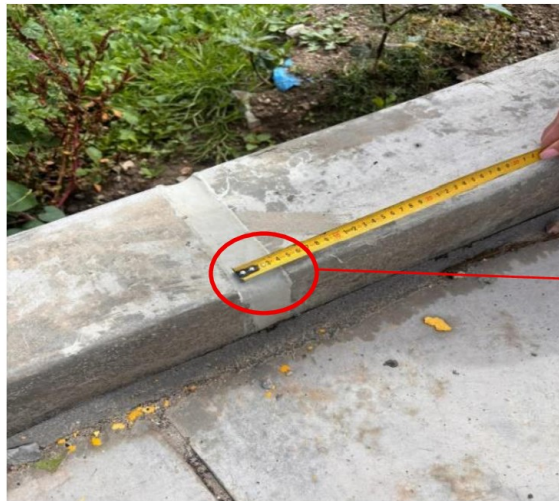
Fotografía n.º 12: Se observa que la junta de dilatación del muro de contención es de 3.5 cm.
