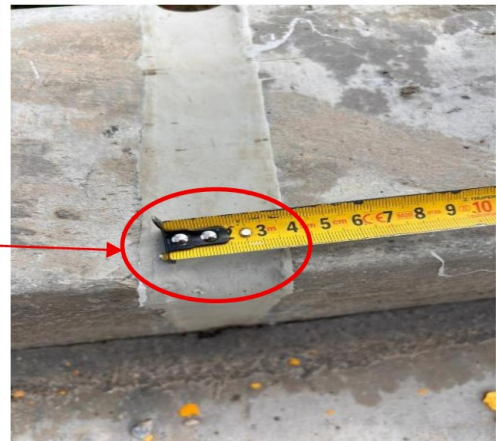
Fotografía n.º 12: Se observa que la junta de dilatación del muro de contención es de 3.5 cm.
