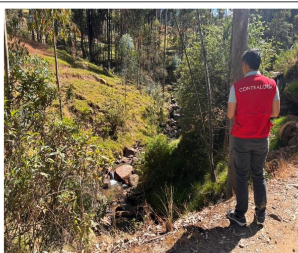
Fotografía N° 1 Inexistencia de Diques
