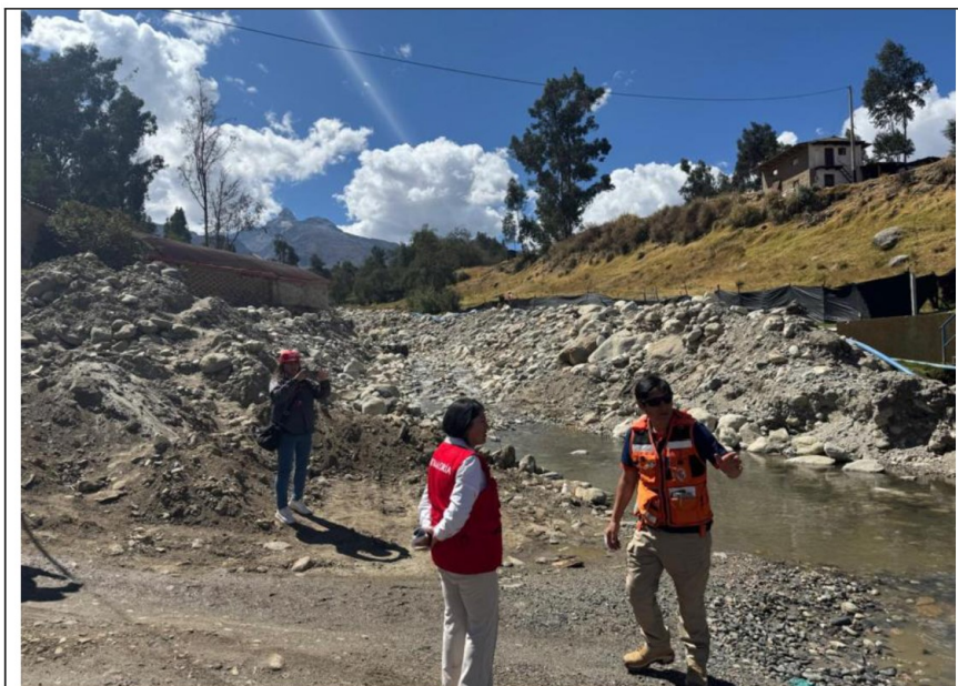
Foto N°04: Verificación de descolmatación en el Río Casca, sector Paria Wilcahuain, realizado conjuntamente con el personal de la Municipalidad distrital de Independencia. (Tramo I)
