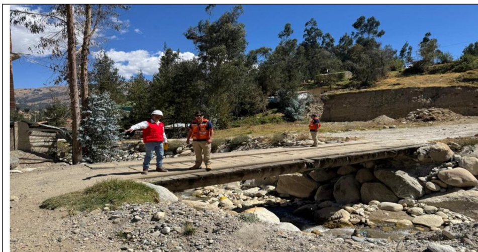
Foto N°05: Verificación de descolmatación en el Río Casca, sector Paria Wilcahuain, realizado conjuntamente con el personal de la Municipalidad distrital de Independencia. (Tramo II)
