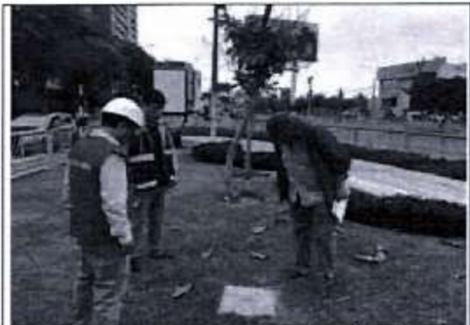
Verificación del Punto Geodésico ubicado en la Berma central de la intersección de la Av. Circunvalación del Golf Los Incas y Av. Javier Prado
