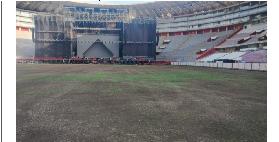
Imagen n.º 4 Trabajos de instalación de estructura metálica para escenario de concierto del viernes 17/04/2026, 48 después de ocurrida la visita de control
