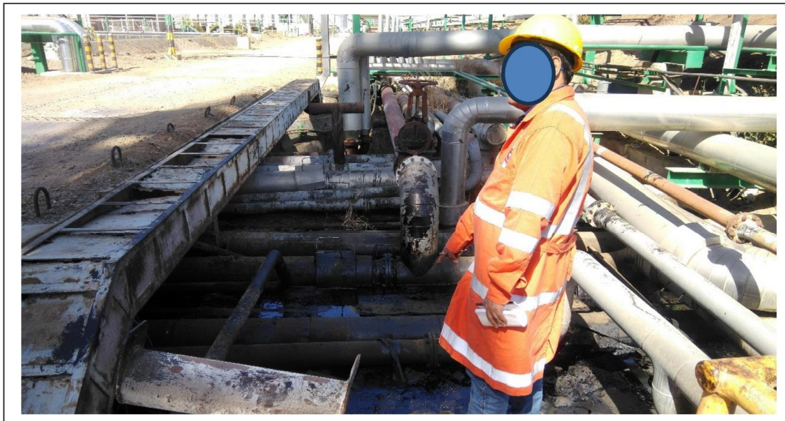
Fotografía n.º 1 Refinería de Talara - Zona de Racks Principal
