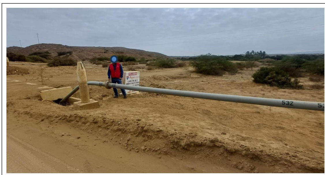
Fotografía n.º 14 Oleoducto Overales – Ducto entre los tramos 532 y 533
