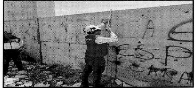
FOTOGRAFÍA N° 32 VERIFICACION DE MURO DE H=10.00 RELLENADO HASTA UN 80% DE SU ALTURA
