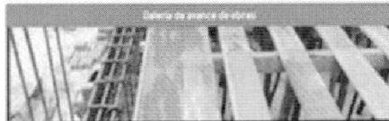
FOTO N°21. Se observa el acero en vigas con medidas de los planos.
