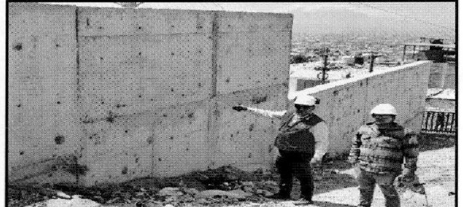
FOTOGRAFÍA N° 34 VERIFICACION DE MURO DE H=7.50 RELLENADO HASTA UN 40% DE SU ALTURA
