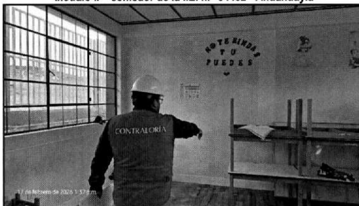
Fotografía n.º 16 Modulo II – comedor de la I.E. n.º 34482 - Andahuayla
