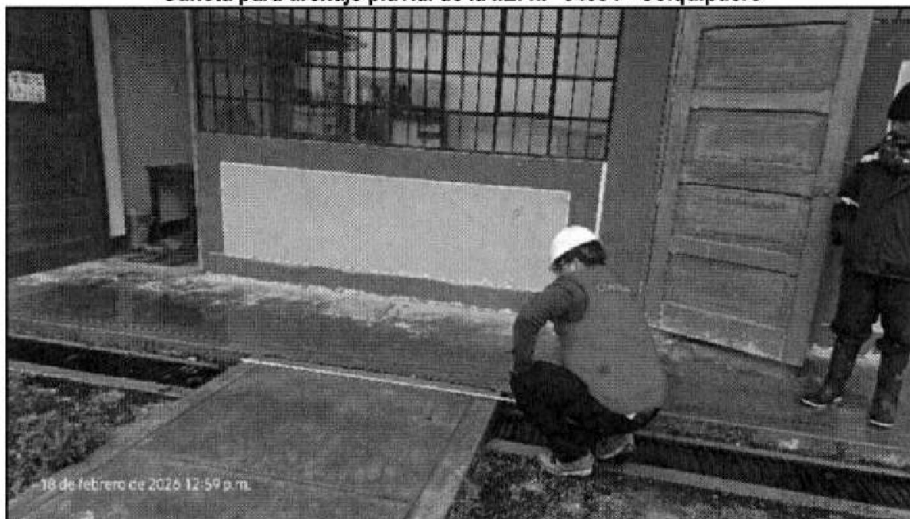
Fotografía n.º 13 Cuneta para drenaje pluvial de la I.E. n.º 34684 - Colquipucro
