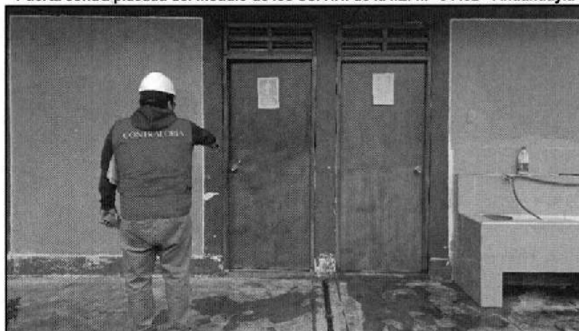
Fotografía n.º 31 Puerta contra placada del módulo de los SS. HH. de la I.E. n.º 34482 - Andahuayla
