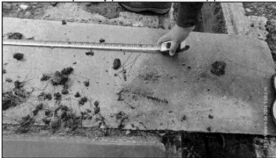
Fotografía n.º 12 Cuneta para drenaje pluvial de la I.E. n.º 34684 - Colquipucro
