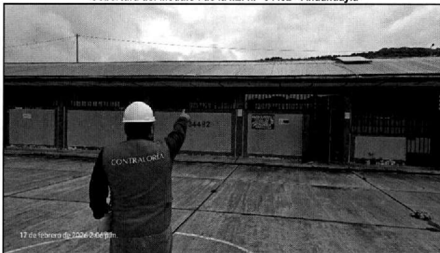
Fotografía n.º 17 Cobertura del Módulo I de la I.E. n.º 34482 - Andahuayla
