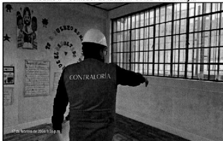
Fotografía n.º 14 Modulo II – comedor de la I.E. n.º 34482 - Andahuayla
