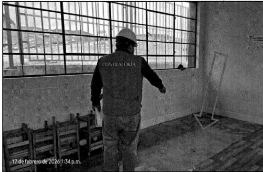
Fotografía n.º 26 Ambiente del comedor del módulo II de la I.E. n.º 34482 - Andahuayla
