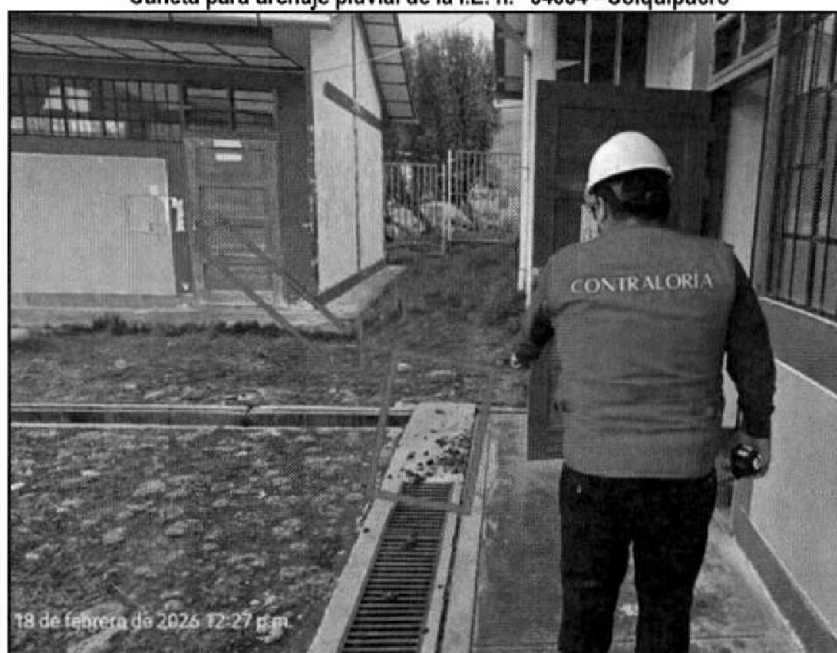
Fotografía n.º 10 Cuneta para drenaje pluvial de la I.E. n.º 34684 - Colquipucro
