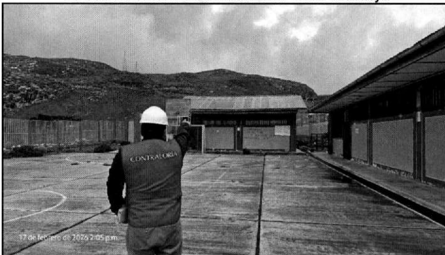
Fotografía n.º 18 Cobertura del Módulo II - comedor de la I.E. n.º 34482 - Andahuayla
