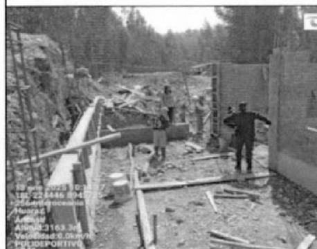
FOTOGRAFIA N° 21 Detalle de construcción en proceso y presencia de personal.
