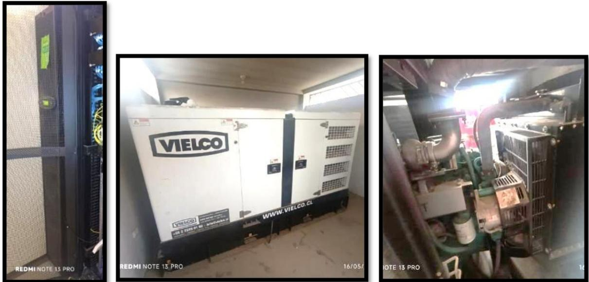
En las fotografías n.ºs 16, 17 y 18, se aprecia la existencia de unidades UPS así como de un grupo electrógeno de 50KW, marca Vielco, como equipos de respaldo de energía al sistema de videovigilancia, los cuales no estarían siendo utilizados ante los constantes cortes de fluido eléctrica que se presentan en el distrito de Florencia de Mora.
