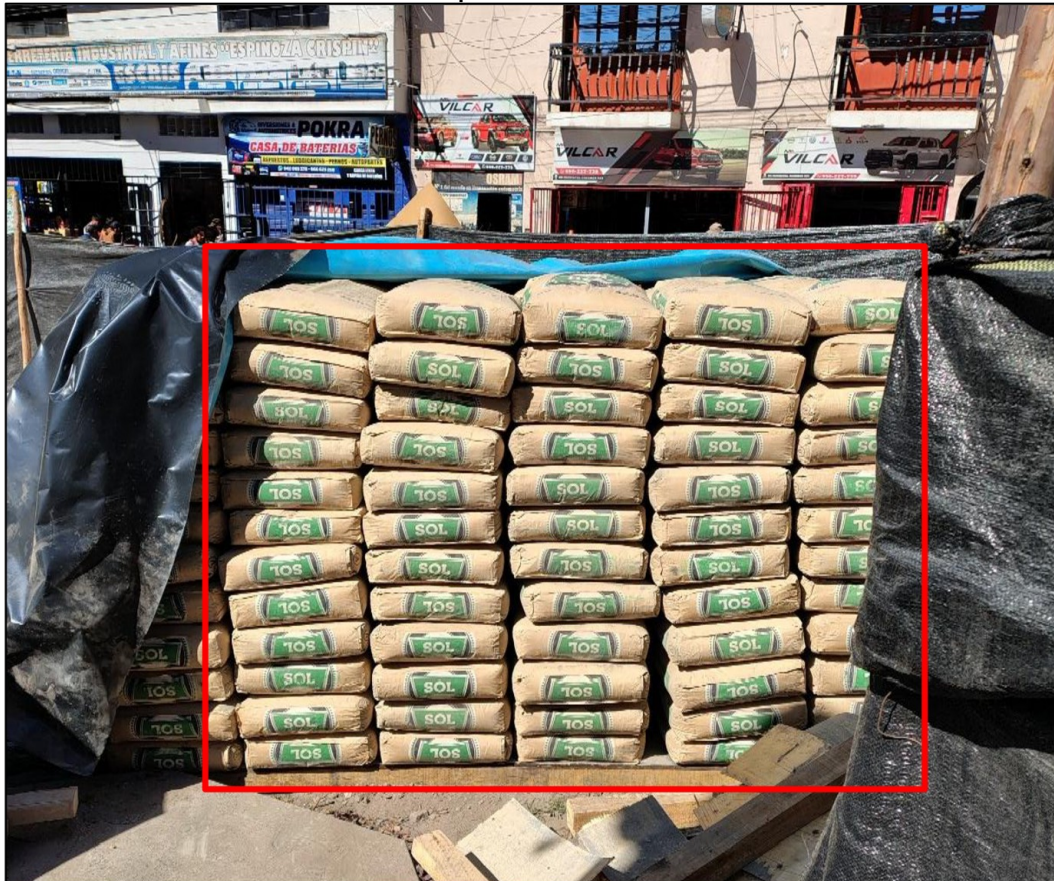
Imagen n.º 1 El cemento se encuentra apilado en columnas de hasta 12 unidades
