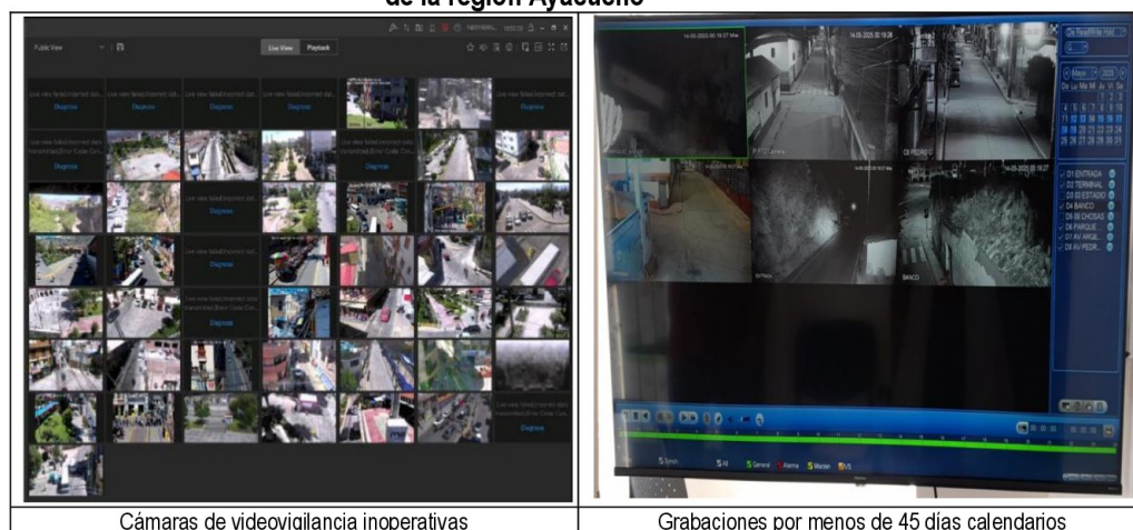
Panel fotográfico n.º 1 Muestra fotográfica del estado de las cámaras de videovigilancia de las municipalidades de la región Ayacucho
