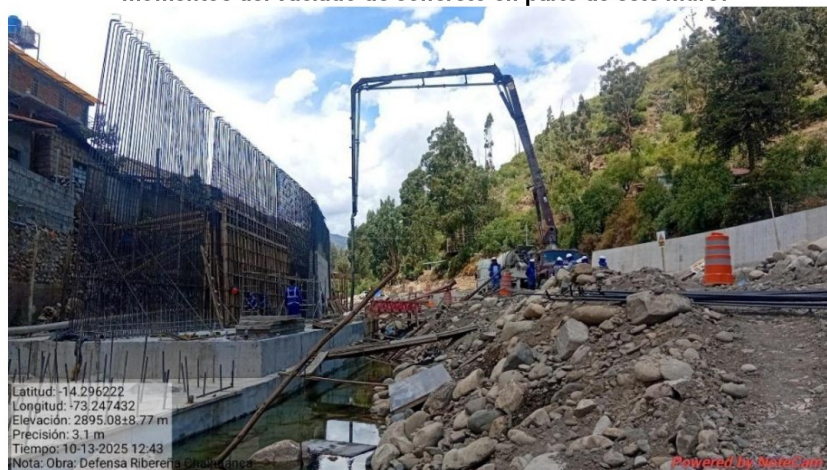
Imagen n.° 14 Zapara y muro estructural de protección [muro tipo 1 en el tramo 6 - margen derecha] momentos del vaciado de concreto en parte de este muro.
