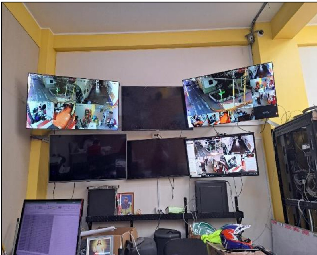
Imagen n.º 4 Cámaras de videovigilancia que no transmiten información por falta de mantenimiento
