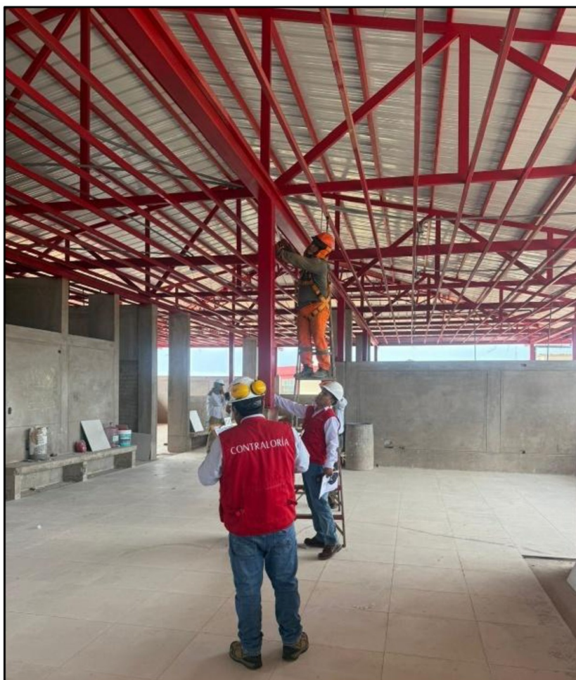
Imagen n.º 10 Medida de las columnas metálicas con la ayuda de un personal obrero
