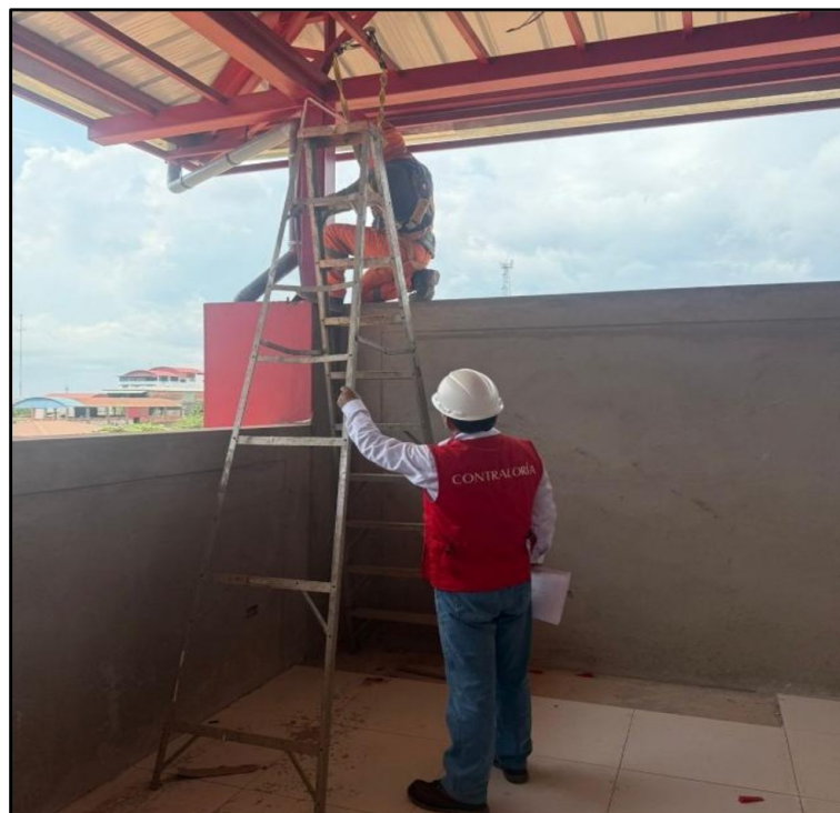
Imagen n.º 9 Medida de las columnas metálicas con la ayuda de un personal obrero
