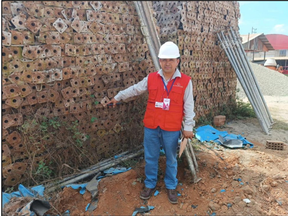
Imagen n.º 10 Puntales metálicos galvanizado de altura variable de 2m a 4m marca Poseidón
