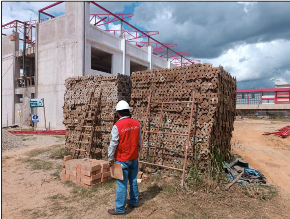
Imagen n.º 11 Puntales metálicos galvanizado de altura variable de 2m a 4m marca Poseidón
