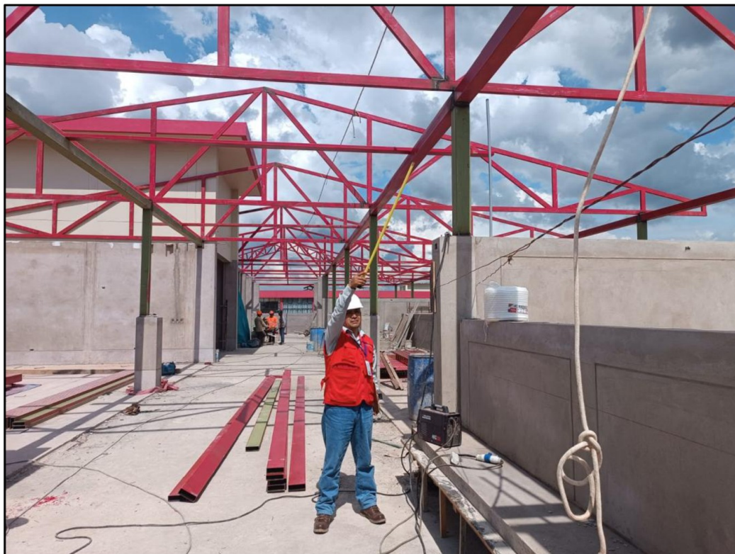
Imagen n.º 9 Anclajes columnas vigas cerchas metálicas en tercer nivel
