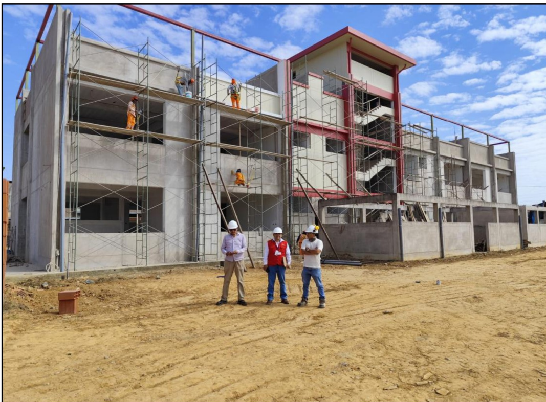
Imagen n.º 5 Imagen al 15 de julio de la infraestructura de tres niveles
