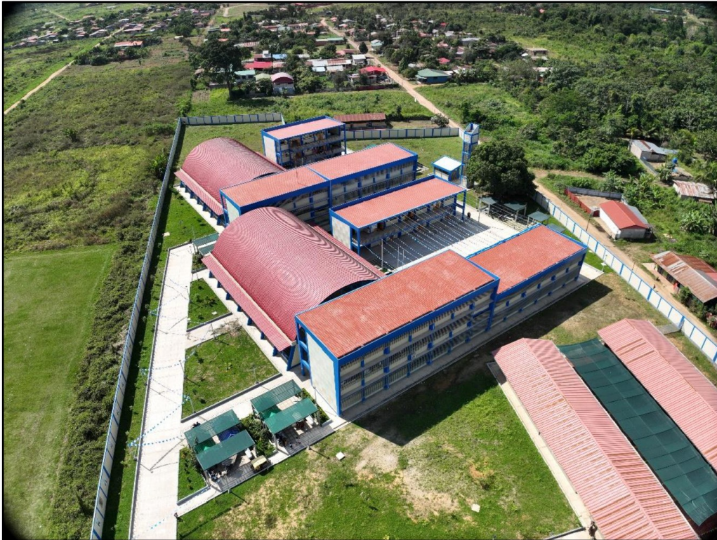
Imagen n.º 3 Vista aérea de la infraestructura educativa ejecutada
