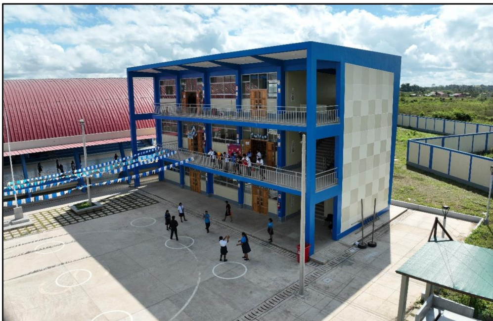
Imagen n.º 7 Bloque n.º 6 no cuenta con rampas ni ascensor
