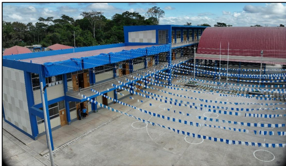
Imagen n.° 8 Bloque 1 y 2 con SS.HH. solo en primer nivel
