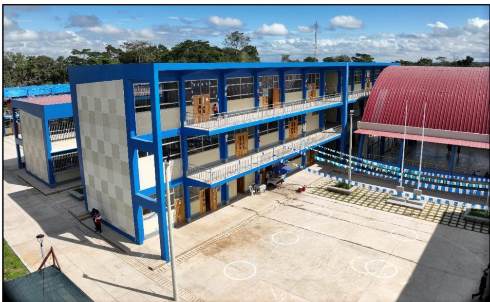
Imagen n.º 6 Bloque 4 y 5 no cuenta con rampas ni ascensor
