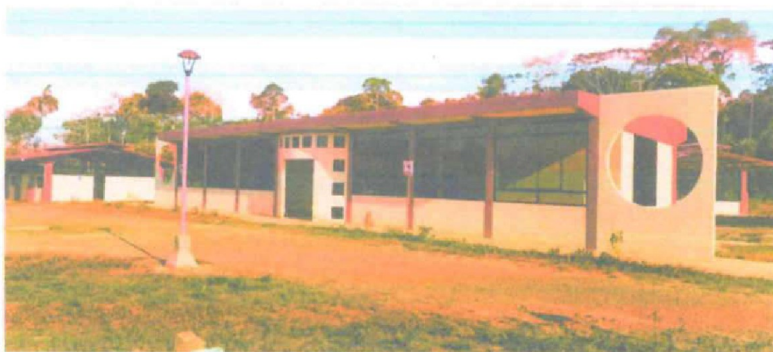
IMAGEN 22. VISTA PANORÁMICA DEL BLOQUE 02.
