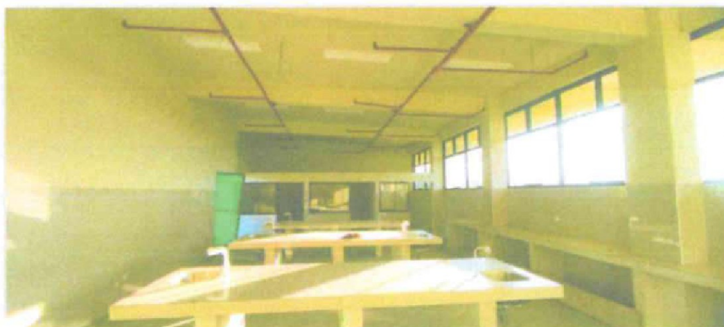
IMAGEN 18. SE ENCONTRARON TUBERÍA DE RED CONTRA INCENDIO PINTADAS.
