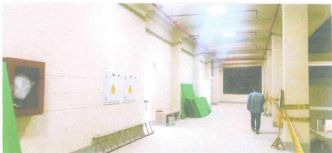
IMAGEN 06. VISTA PANORÁMICA DEL CORREDOR EN EL SEGUNDO NIVELSE APRECIAN EL TABLERO ELECTRICO Y TABLERO DE INSTALACIONES ESPECIALES.
