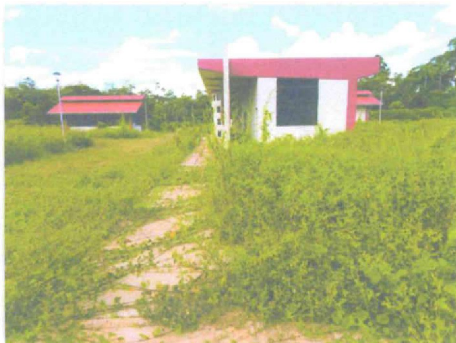
IMAGEN 09. VISTA DE BLOQUE ADMINISTRATIVO, EMBALZAMADO, VEREDAS Y ACCESO CON VEGETACIÓN EN LA ZONA 02.
