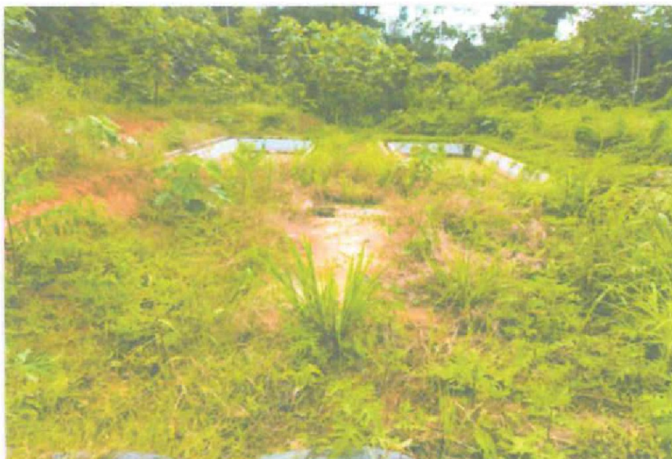
IMAGEN 11. AREA DEL PTAR CON VEGETACIÓN EN LA ZONA 02.
