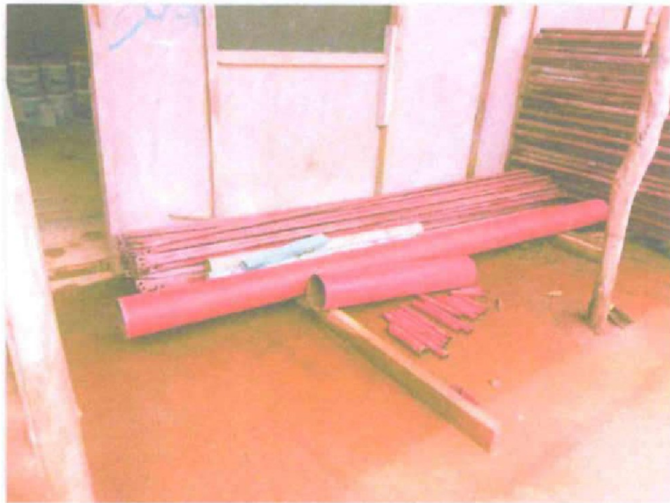
IMAGEN 16. VISTA EXTERNA DE ALMACEN DE OBRA, COMO SE ENTREGÓ A LA UNIDAD EJECUTORA.
