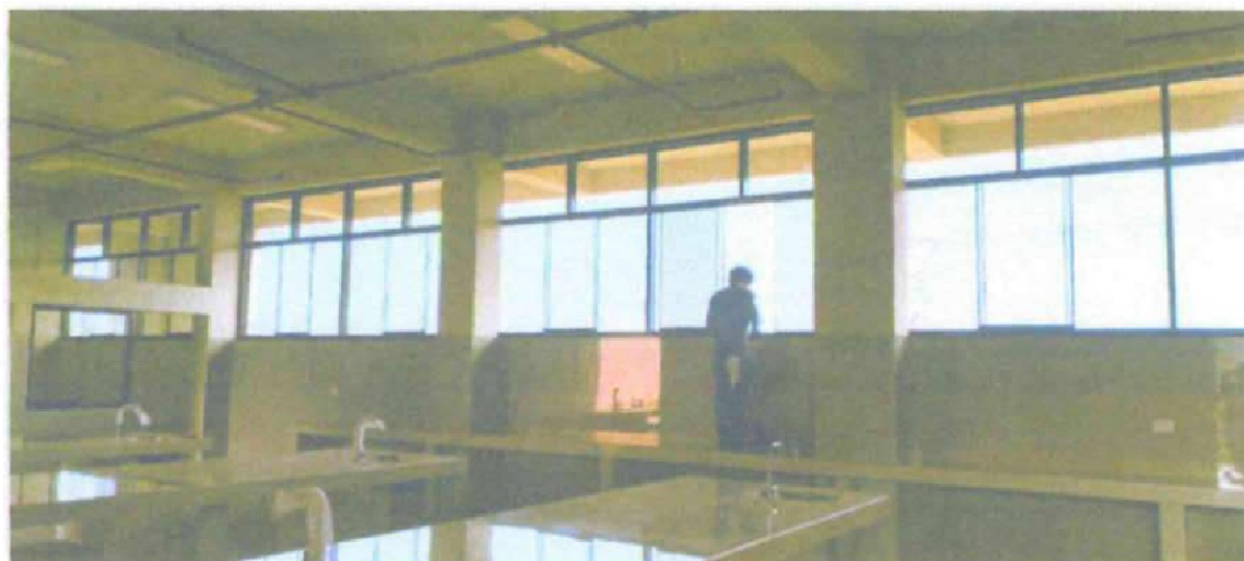
IMAGEN 03. INSTALACIONES DE LAS VENTANAS EN LA ZONA 01.
