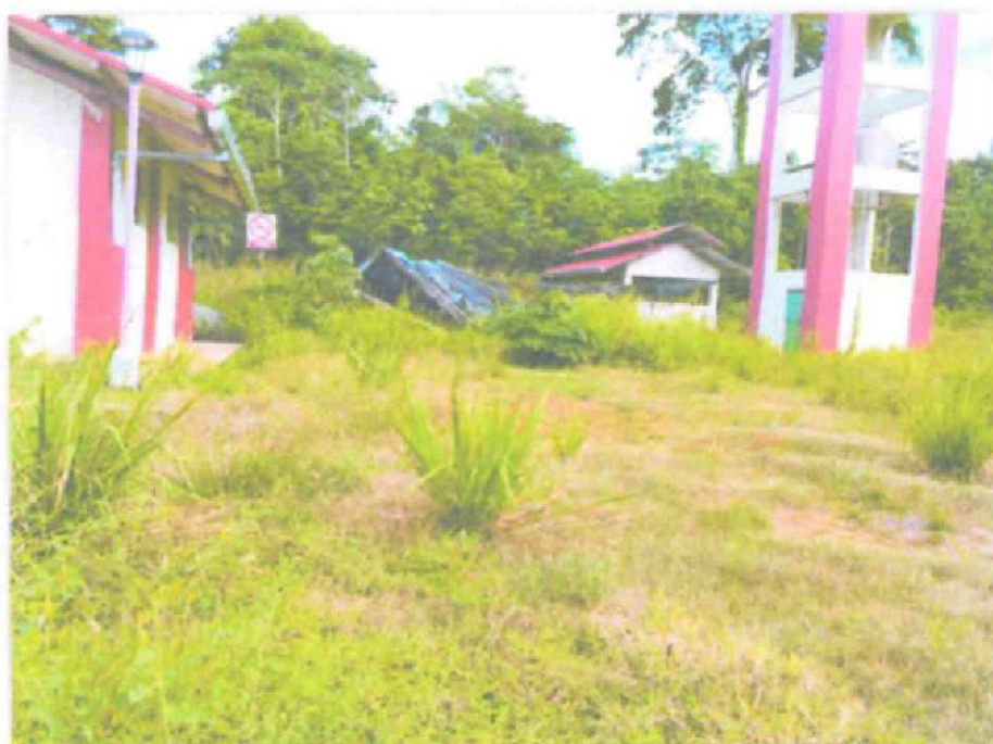
IMAGEN 08. VISTA DE TALLER DE SOLDADURA CAÍDO EN LA ZONA 02.
