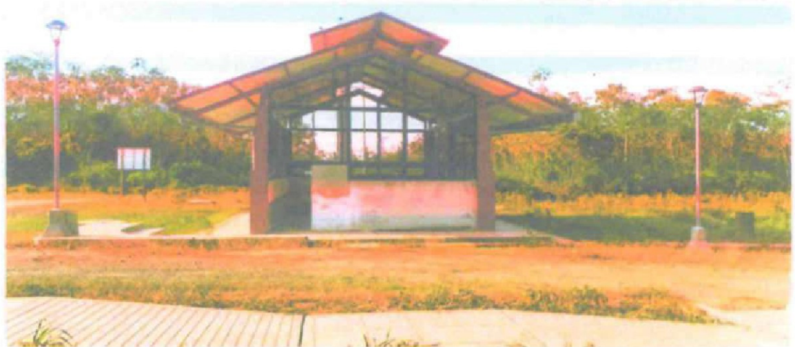
IMAGEN 27. VISTA PANORÁMICA DEL MÓDULO DE EMBALSAMADO DE LA ZONA 02.
