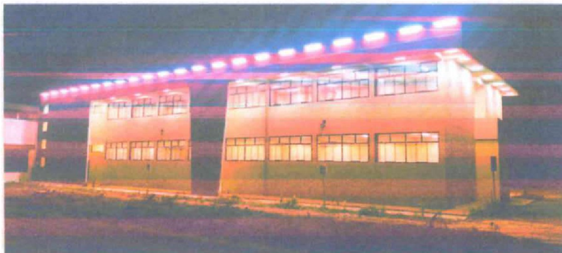
IMAGEN 01. VISTA PANORÁMICA DE LA ZONA 01, DONDE SE APRECIAN EL FUNCIONAMIENTO DE LAS LUMINARIAS Y LAS VENTANAS.
