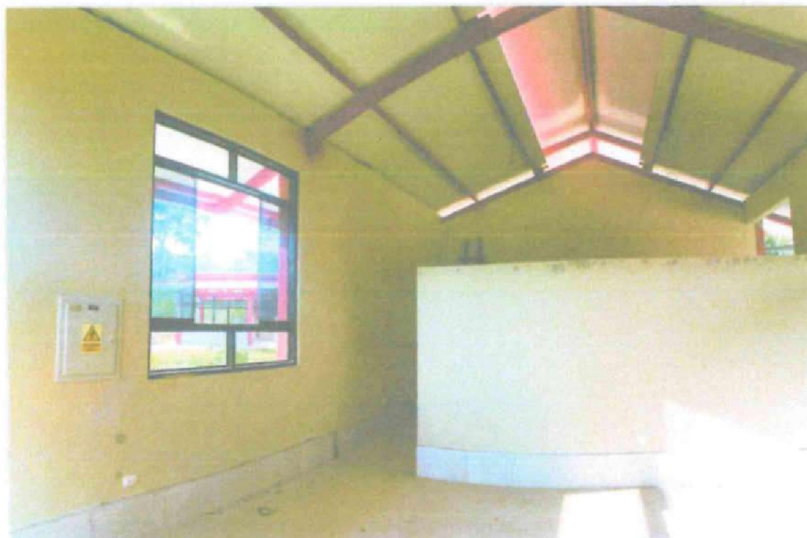
IMAGEN 35. VISTA PANORÁMICA INTERNA DE MODULO DE ALMACEN 02 DE LA ZONA 02.
