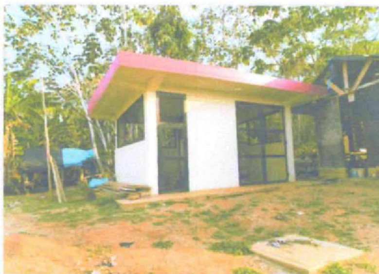
IMAGEN 07. VISTA PANORÁMICA DE CASETA DE FUERZA DE LA ZONA 01.
