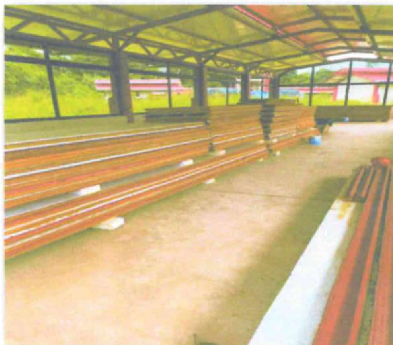
IMAGEN 17. VISTA DE COBERTURAS TERMOACUSTICA EN MODULO DE AVES DE LA ZONA 02.
