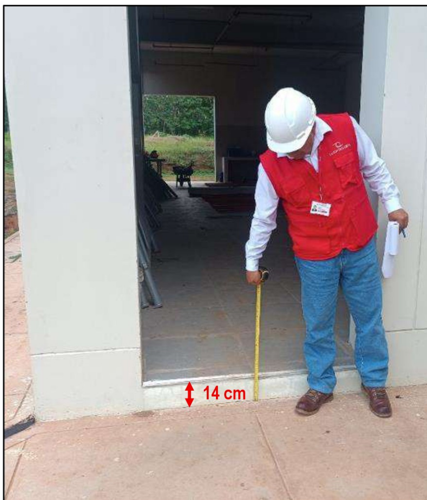
Imagen n.º 1 Desnivel de catorce (14) centímetros en el ambiente para laboratorio de cirugía de animales mayores
