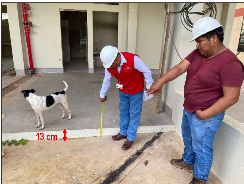
Imagen n.º 2 Desnivel de trece (13) centímetros entre la vereda y el ingreso al pasadizo principal del primer nivel
