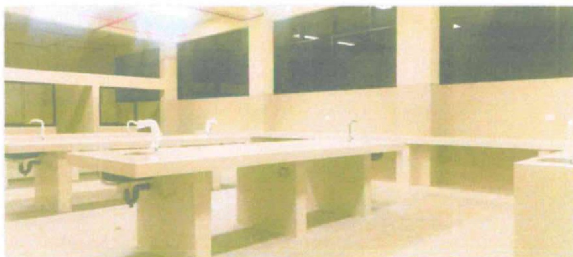
IMAGEN 04. VISTA PANORÁMICA DE MESAS DE LABORATORIO CON GRIFERIA INSTALADA.
