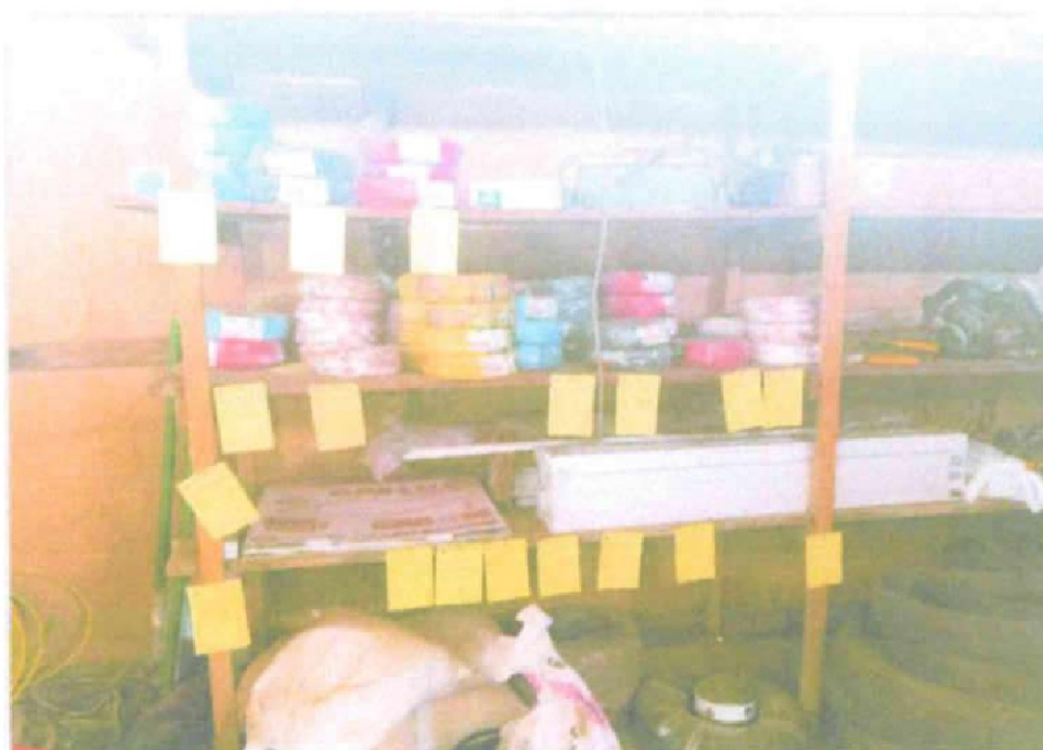
IMAGEN 16. VISTA DE ALMACEN DE OBRA, COMO SE ENTREGÓ A LA UNIDAD EJECUTORA.
