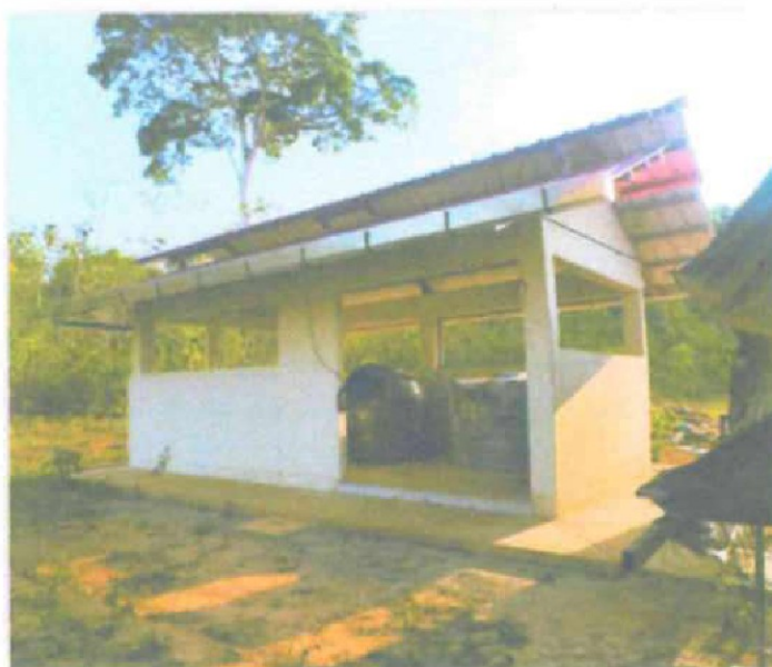
IMAGEN 44. VISTA PANORÁMICA DE CASETA DE TRATAMIENTO DE AGUA POTABLE DE LA ZONA 02.
