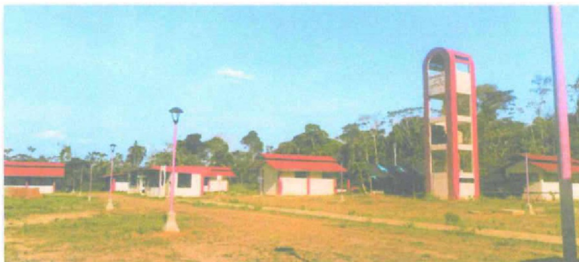
IMAGEN 42. VISTA PANORÁMICA DEL TANQUE ELEVADO DE LA ZONA 02.
