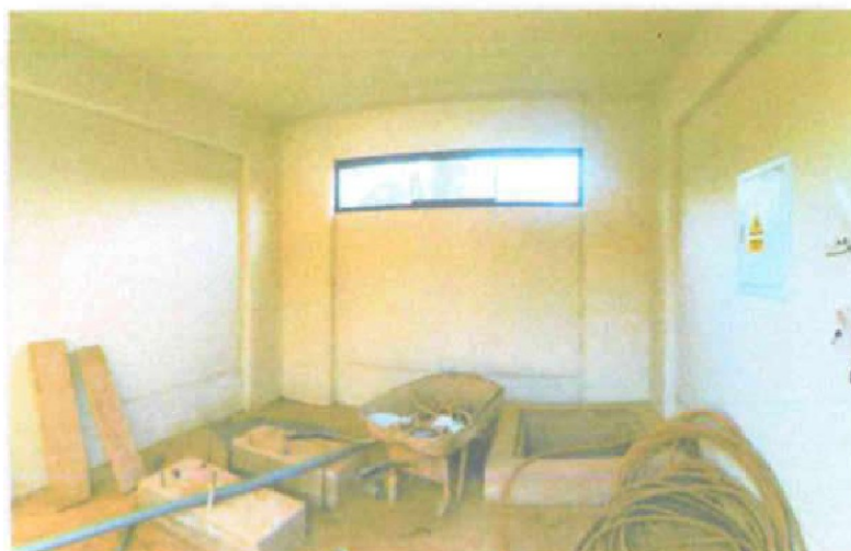
IMAGEN 43. VISTA INTERNA DEL TANQUE ELEVADO DE LA ZONA 02.
