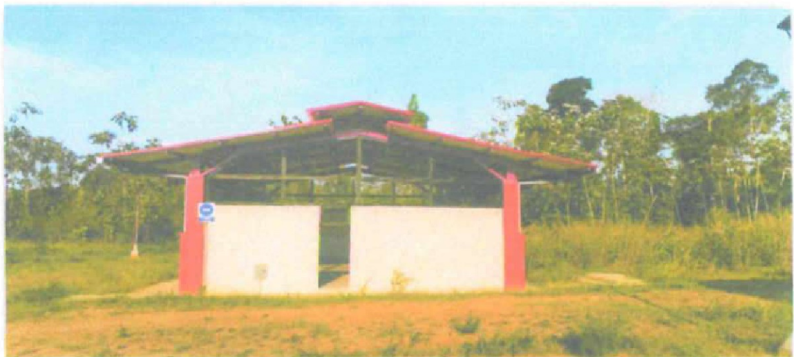
IMAGEN 29. VISTA PANORÁMICA INTERNA DEL MÓDULO DE CRIANZA DE CUYES EN LA ZONA 02.
