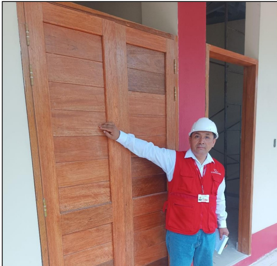
Imagen n.º 4 La puerta no cuenta con un elemento que permite visualizar al interior
