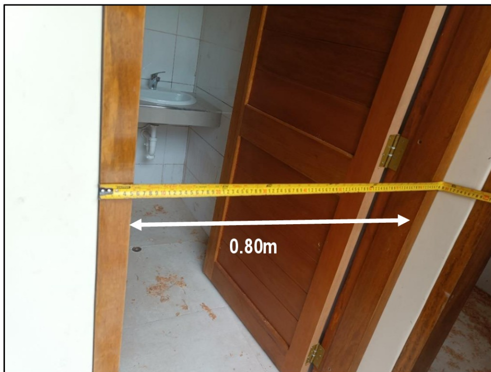
Imagen n.° 5 Ancho de la puerta de servicio higiénico de personas con discapacidad
