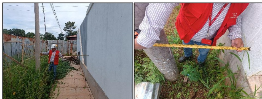
Imagen n.° 17 Alineamiento y ubicación de postes con respecto al perímetro del cerco perimétrico
