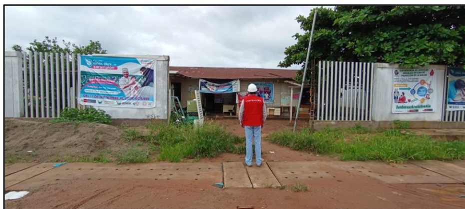
Imagen n.º 24 Estado actual de la infraestructura
