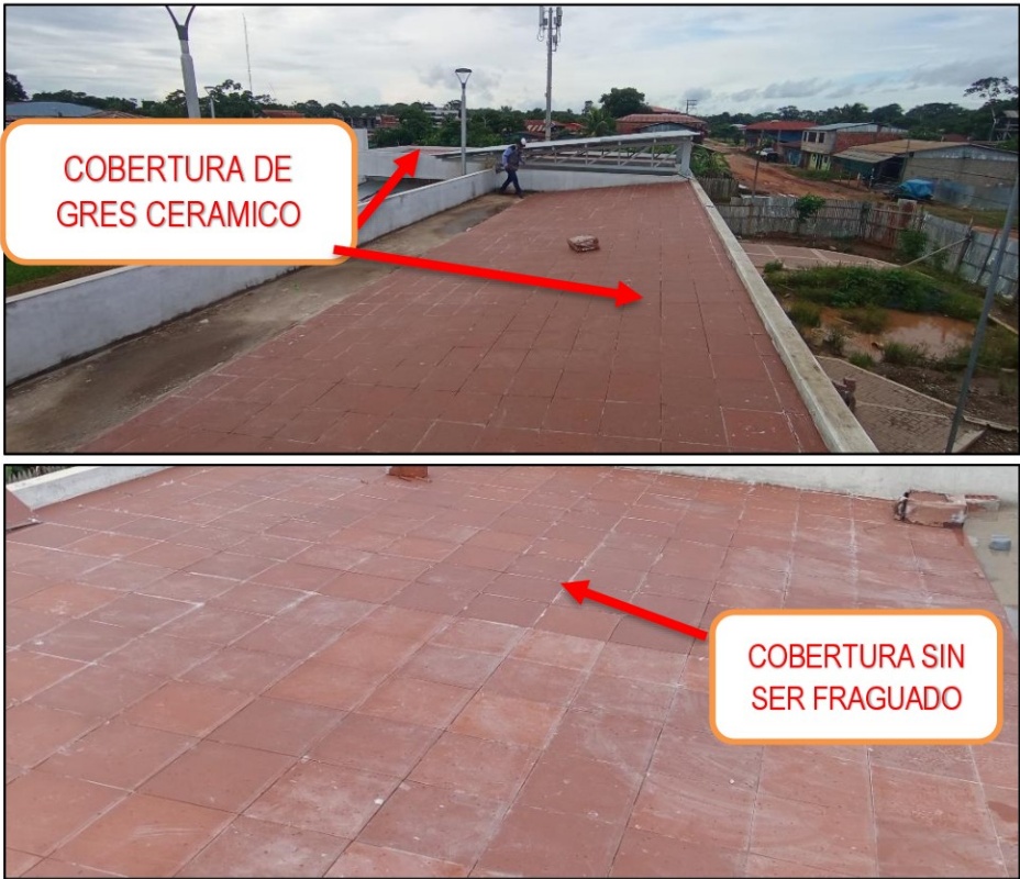
Imagen n.º 23 Mediciones realizadas por la comisión de control en Partidas en Cubierta y Cobertura
