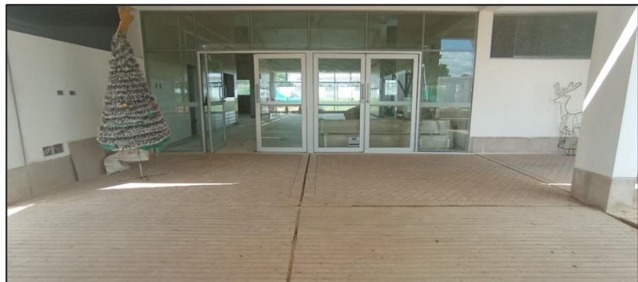
Imagen n.º 19 No se evidencia la instalación de señalización según requerimientos
