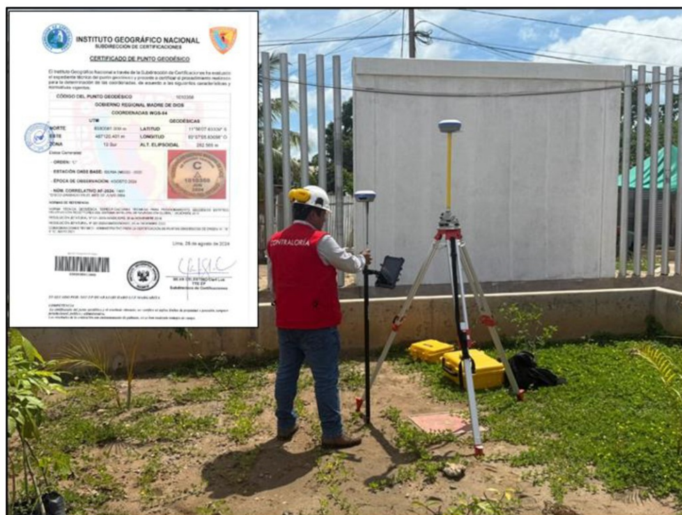
Imagen n.º 13 Instalación del GPS Diferencial 6 en el Punto Geodésico Certificado de orden C
