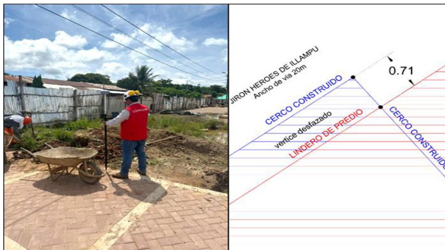
Imagen n.° 16 Verificación del vértice P2
