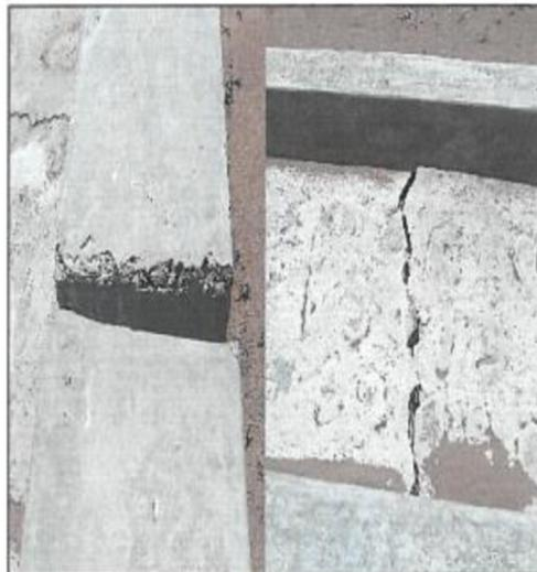
**Fotografía n.º 3:** Se aprecia desplazamiento de las juntas de dilatación de los muros, fisuras y socavación de las losas del canal de concreto de evacuación.
