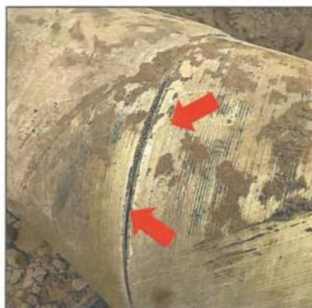
Imagen n.º 2: Se verificó la rotura de tubería de políéster reforzado con fibra de vidrio (GRP) con una longitud aproximada de 1.60 ml en la tubería de 800 mm.
