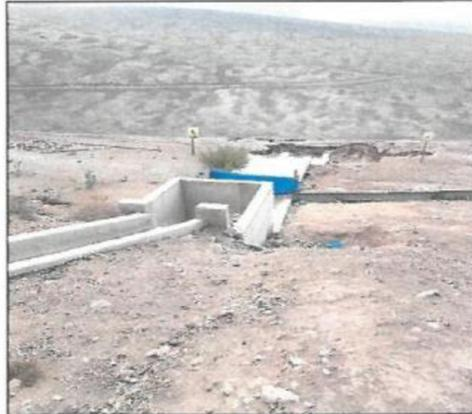
Imagen n.º 2: Cámara, canal de evacuación y badén de concretos ejecutado para el transporte, descarga y evacuación de los sedimentos sólidos en suspensión, decantados y retenidos como excedencias de agua del reservorio hacia una quebrada.
