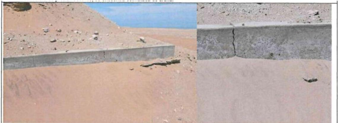
**Fotografía N° 444 y 445:** Se verificó que el canal de evacuación que conduciría el agua que sea expulsada por la válvula de alivio de la cámara reductora de presión PRV-10, fue fundada sobre suelo natural, cuya cimentación se viene socavando por la presencia del viento propio de la zona, asimismo, se presente una fisura vertical por el asentamiento que viene sufriendo el mismo.
