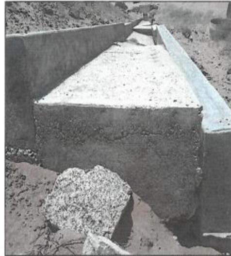
**Fotografía n.º 2:** Se advierte el colapso y socavación de los paños del canal de concreto para evacuación, debido al contacto del agua con el terreno de fundación arenoso limoso.
