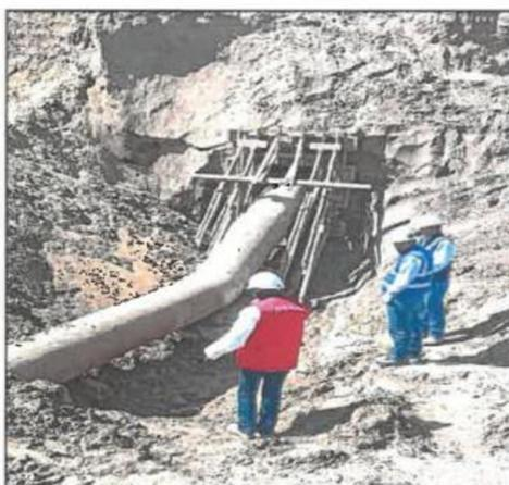
Imagen n.º 1: Verificación de los trabajos de excavación realizados en el km 6+250 para descubrir la tubería, se cuenta con la participación del residente e inspector del proyecto.
