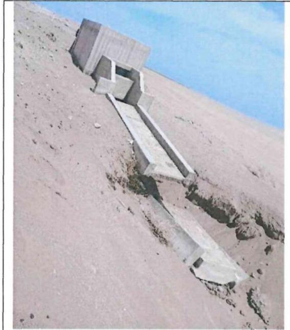
**Fotografía N° 482:** Vista exterior de la cámara de la válvula de purga VP-18, constatándose que ha colapsado el canal de drenaje de agua por la socavación de su base de apoyo del canal, verificándose que este se fundó directamente sobre suelo natural (arena limosa).
