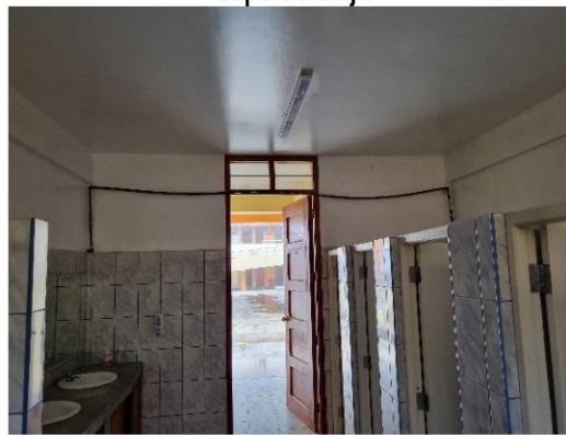
Imagen n.º 36 Tubería para el paso de agua caliente en el baño de alumnas no se encuentra descansando en una superficie fija
