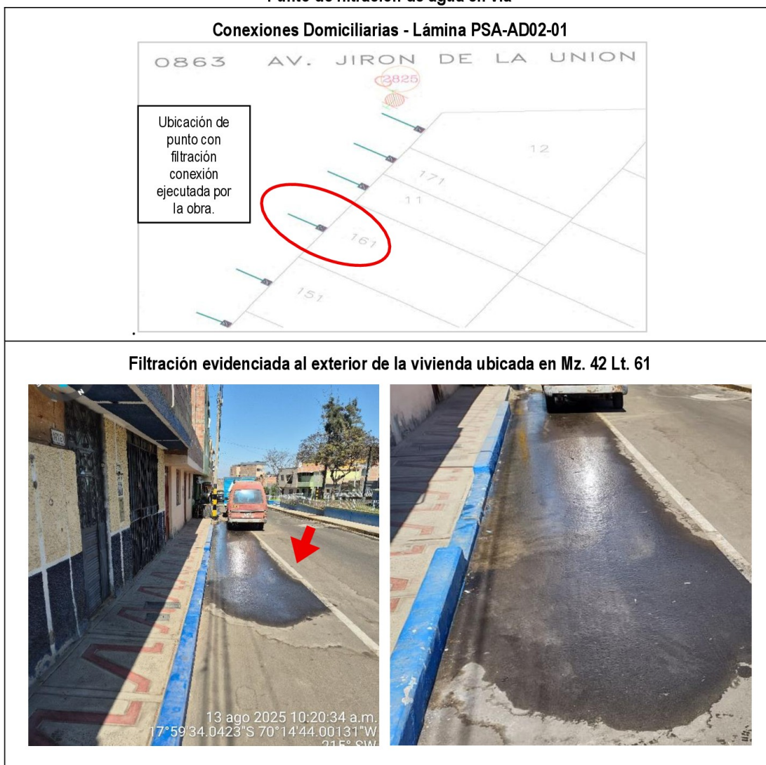
Panel fotográfico n.° 4 Punto de filtración de agua en vía
