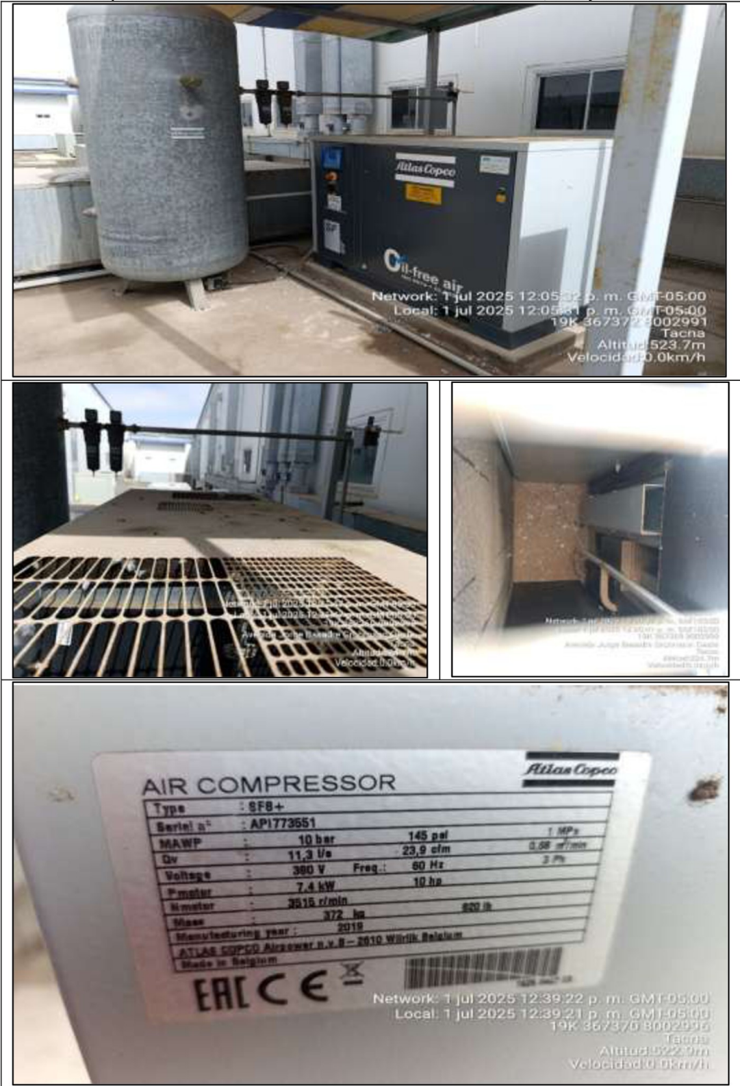
Panel fotográfico n.º 32 Compresor de aire medicinal con número de serie API773551, con oxido, tierra y suciedad
