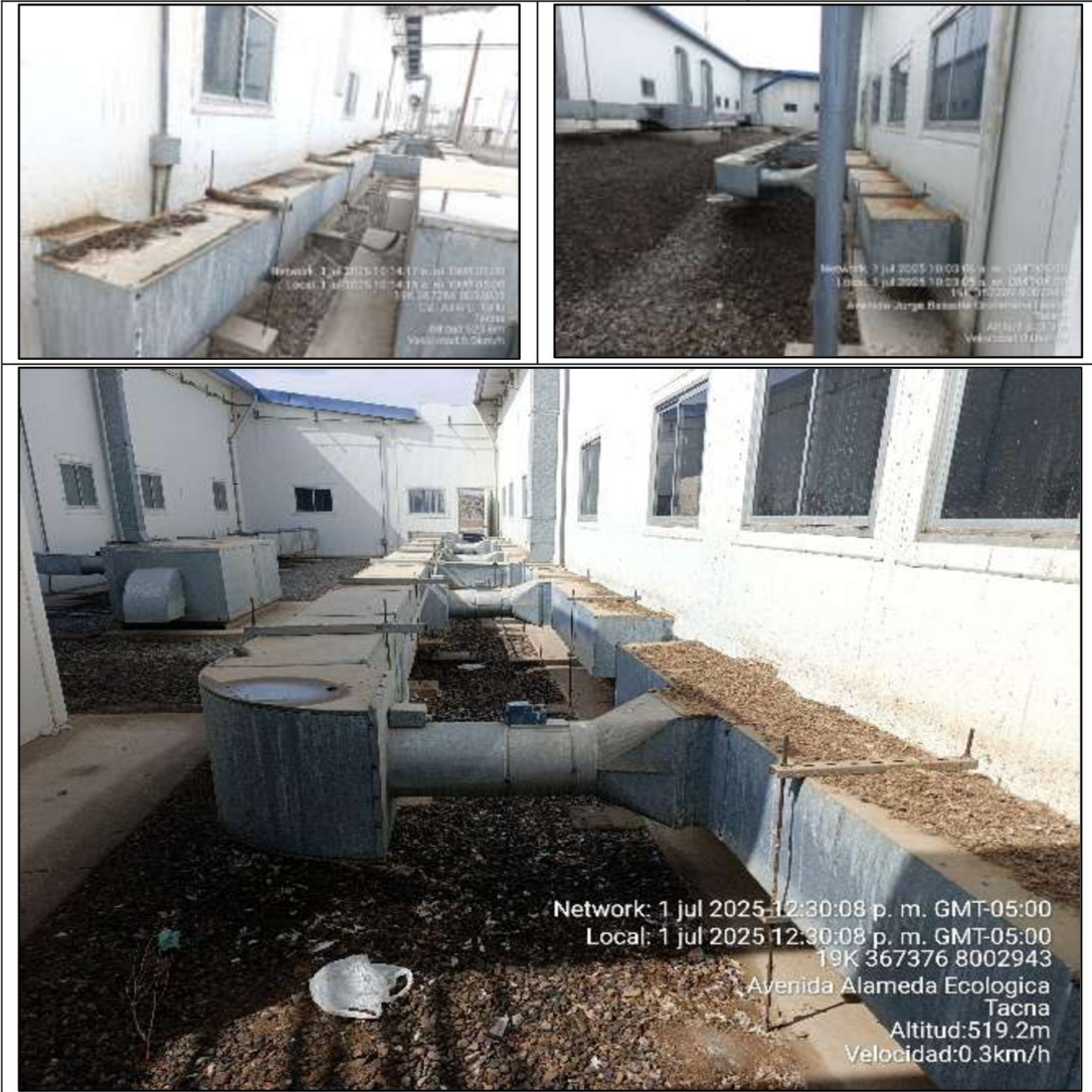
Panel fotográfico n.º 41 Ductos de sistema de ventilación con excretas de paloma
