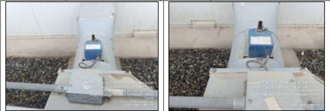
Panel fotográfico n.º 40 Dampers de sistema de ventilación expuestos al clima, presenta oxido en su exterior
