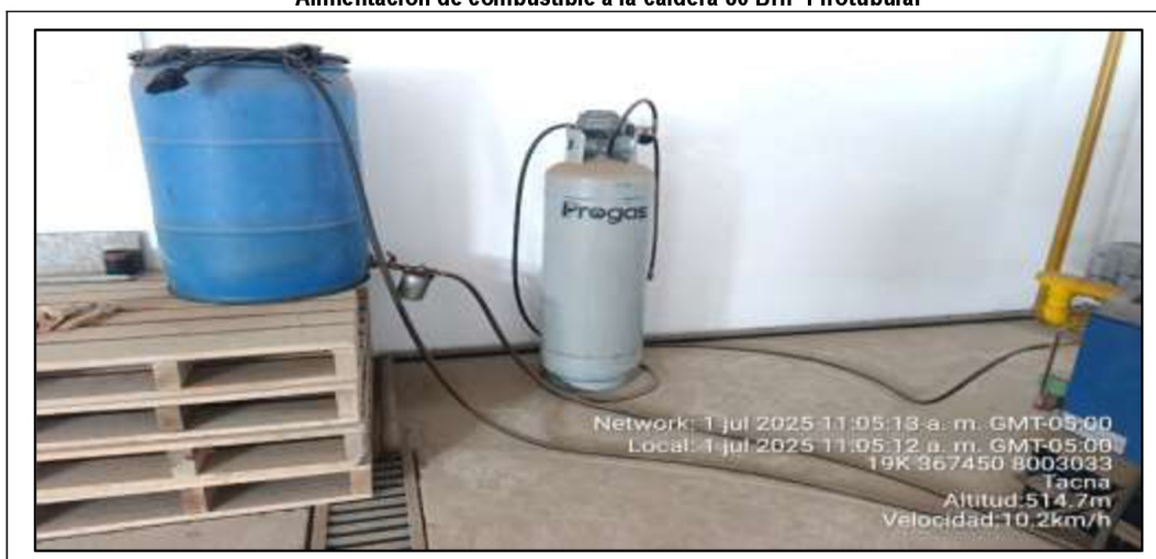
Imagen n.º 2 Alimentación de combustible a la caldera 80 BHP Pirotubular
