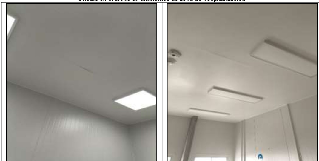
Panel fotográfico n.º 16 Grietas en el techo en ambientes de zona de hospitalización
