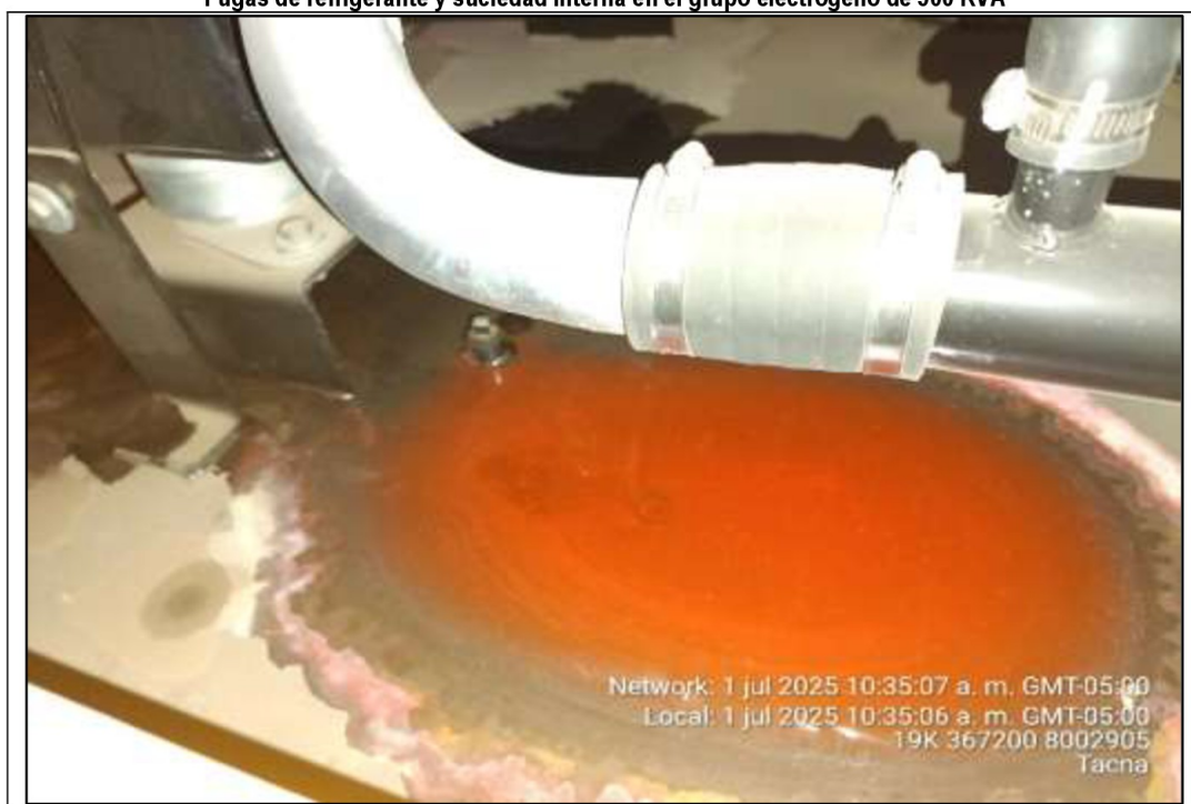
Panel fotográfico n.º 35 Fugas de refrigerante y suciedad interna en el grupo electrógeno de 500 KVA
