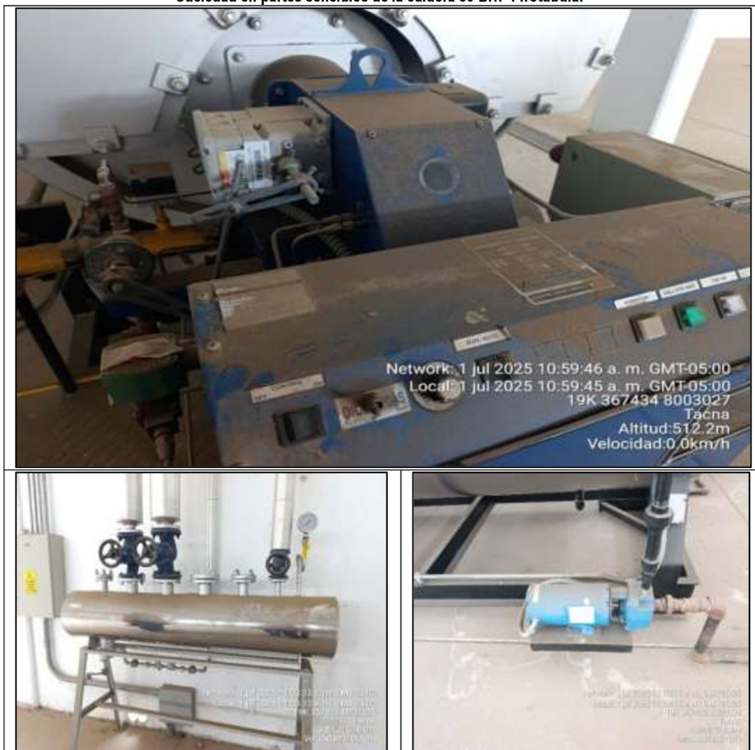
Panel fotográfico n.º 34 Suciedad en partes sensibles de la caldera 80 BHP Pirotubular
