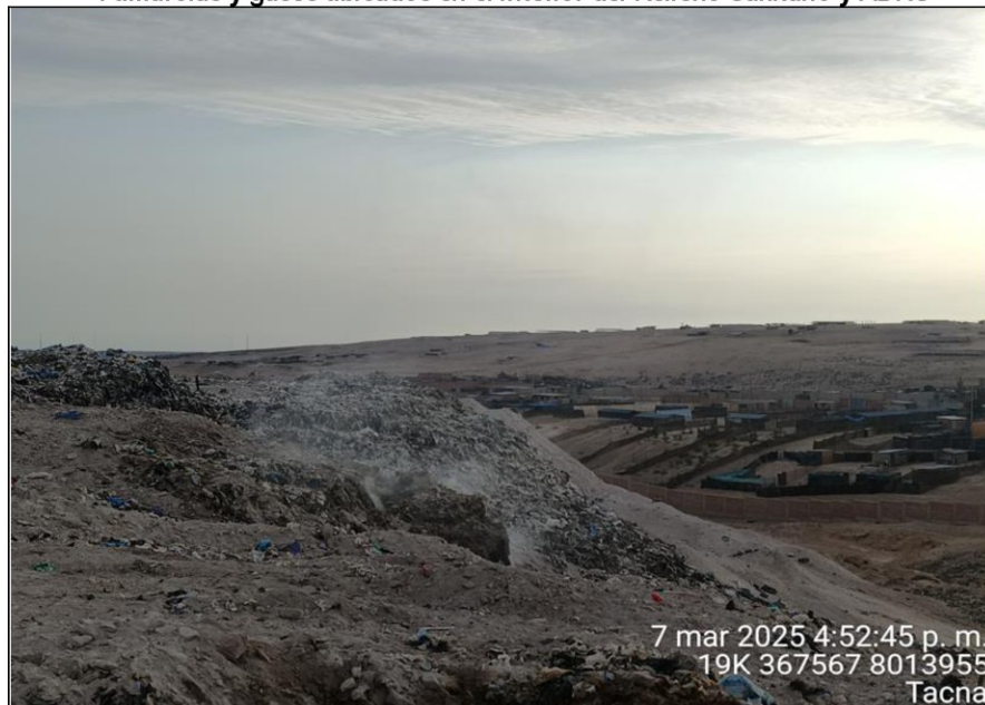
Fotografía n.º 9: Fumarola, remanente de último incendio en el interior del relleno sanitario.
