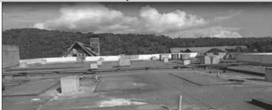
Panel fotográfico n.º 5 Estado Actual de las estructuras metálicas y coberturas de Aluzinc Fotografía n.º 24
