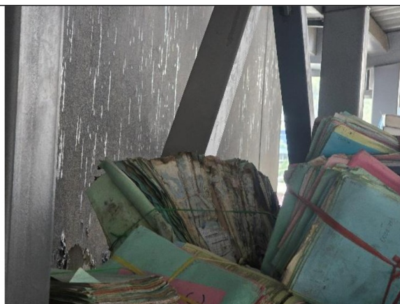
Fotografías n.ºs 12 y 13: Durante la visita se registraron precipitaciones pluviales, constatándose el ingreso de agua al ambiente, afectando los documentos almacenados.
