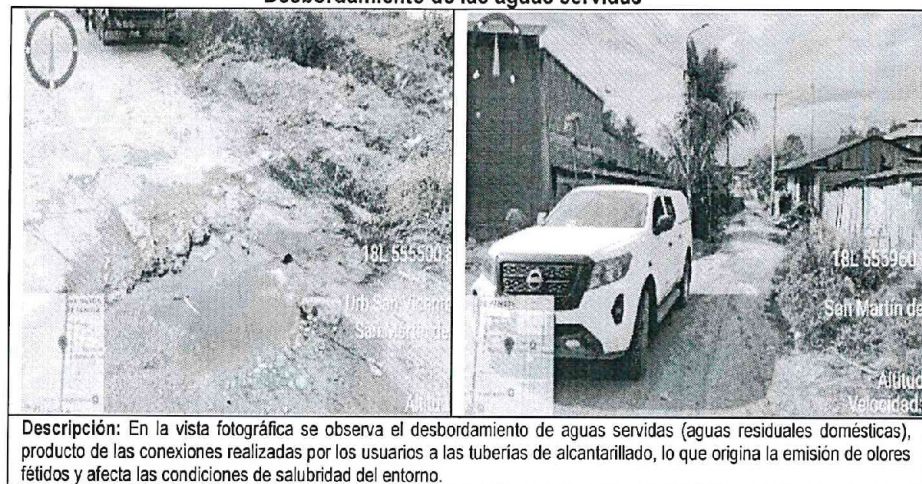
Imágenes n.ºs 26 y 27 Desbordamiento de las aguas servidas
