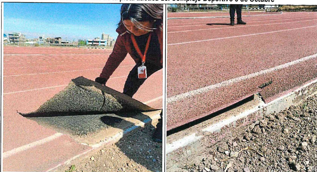
Fotografía n.º 45: Capa de poliuretano (tartán) presenta desprendimiento en varios tramos de la pista atlética.
