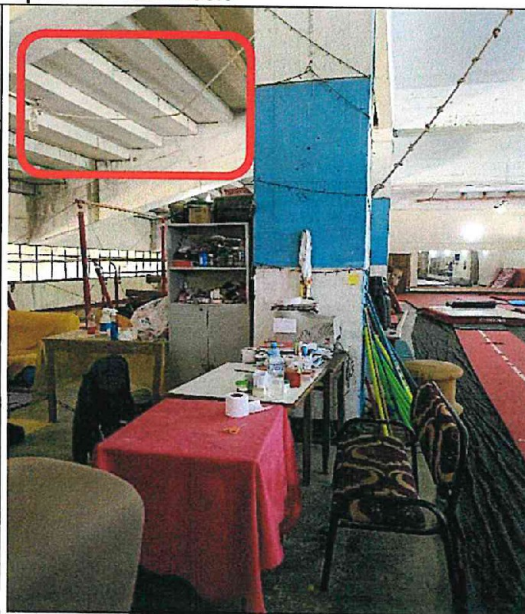
Fotografía n.º 33: Instalaciones eléctricas expuestas y mobiliario no adecuado para el área
