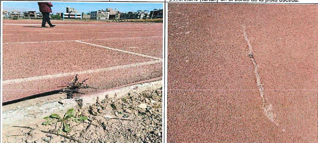
Fotografías n.ºs 47 y 48: Varios tramos de la capa de poliuretano (tartán) presenta fisuras.
