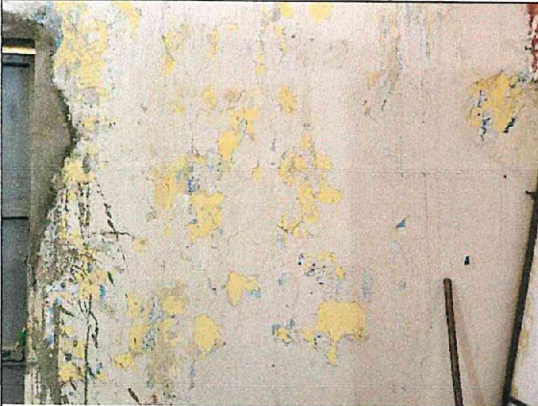
Fotografía n.º 18: Paredes deterioradas con presencia de humedad, filtraciones de agua y desprendimiento de pintura
