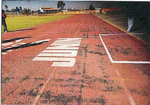
Fotografía n.º 3: Las líneas de demarcación de carril se encuentran ilegibles y la capa de poliuretano (tartán) presenta desgaste.
