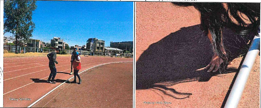
Fotografías n.ºs 49 y 50: La pista de poliuretano (tartán) tienen vacíos de aire y deformaciones, lo cual eleva la superficie formando una pista irregular.
