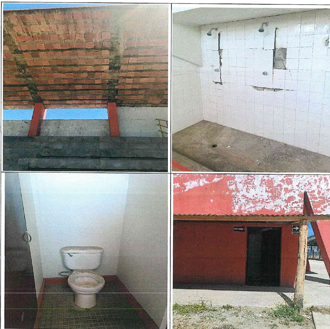
Fotografías n.ºs 80, 81, 82 y 83: Techo de la tribuna occidente sin acabados y con los servicios higiénicos sin mantenimiento correspondiente y con un techo improvisado de madera y calamina rustica.
