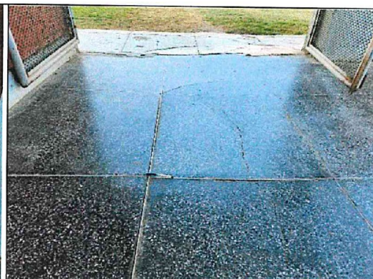
Fotografía n.º 22: Pasadizo de tribuna occidente con desnivel en relación al nivel de piso terminado.
