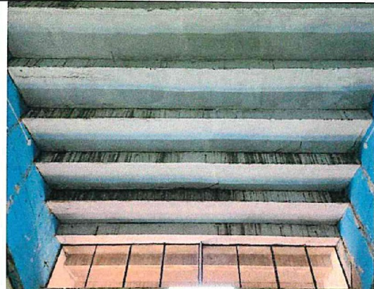
Fotografía n.º 17: Se evidencia que, en el segundo nivel de las graderías, la presencia de humedad producto de la filtración de aguas pluviales.
