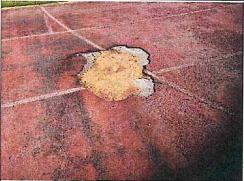
Fotografía n.º 5: Tramo de la capa de poliuretano (tartán) con desprendimiento.
