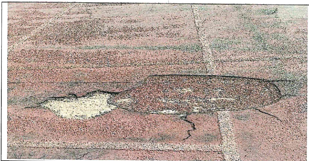
Fotografía n.º 9: Otro tramo de la capa de poliuretano (tartán) con desprendimiento.
