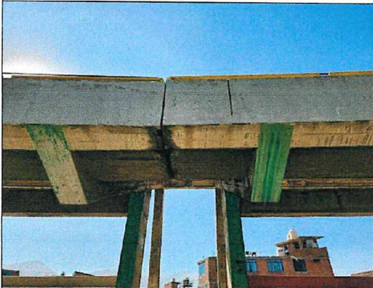
Fotografía n.º 12: Estructura de la tribuna con cubierta inestable, con presencia de desnivel en relación al otro tramo de la tribuna.
