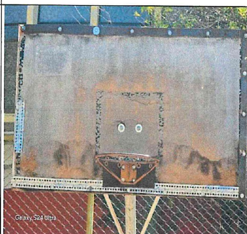
Fotografías n.ºs 57, 58, 59 y 60: La cancha de fútbol de césped natural se encuentra en un mal estado de conservación al observarse inundada por charcos de agua y sin el mantenimiento que requiere el mismo; de igual manera, el tablero de básquet de una de las canchas se encuentra en mal estado de conservación al encontrarse corroído por el óxido.
