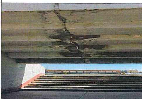
Fotografía n.º 73: Presencia de humedad en las graderías de la tribuna por la filtración de aguas pluviales.
