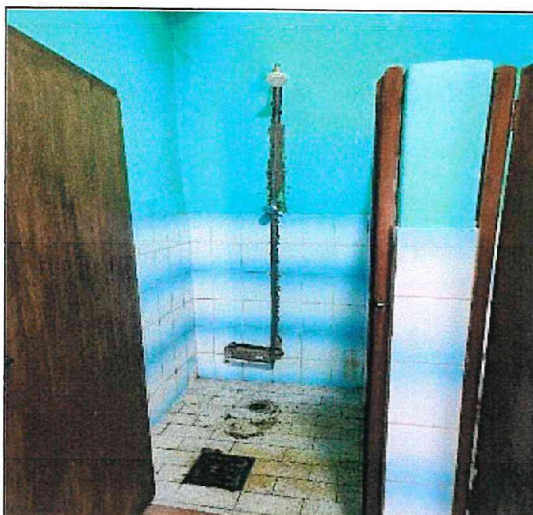
Fotografía n.º 25: Instalaciones sanitarias expuestas y falta de mantenimiento de pisos en duchas.
