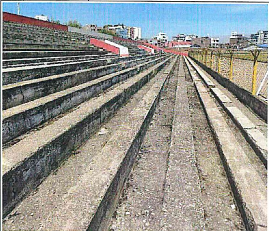
Fotografías n.ºs 74 y 75: Graderías de la tribuna oriente se encuentra sin mantenimiento y con huecos en toda la tribuna.
