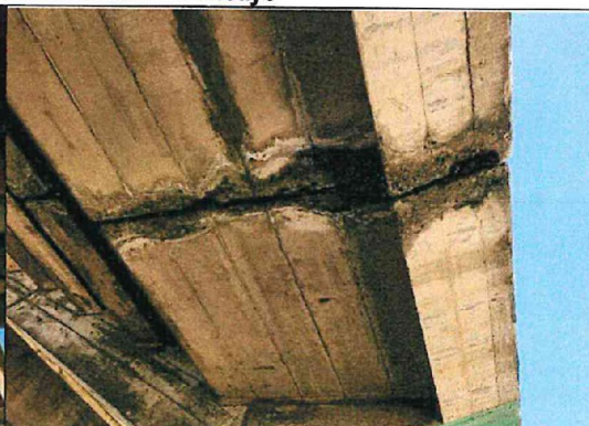
Fotografía n.º 11: Presencia de humedad por filtración en toda la tribuna.
