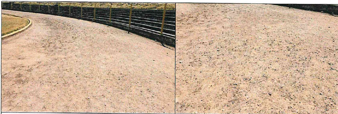
Fotografías n.ºs 66 y 67: Superficie de la pista atlética no se encuentra compactada en todo su recorrido, tampoco cuenta con señalización, presenta diversos baches por la erosión de las aguas pluviales y piedras pequeñas en su superficie.
