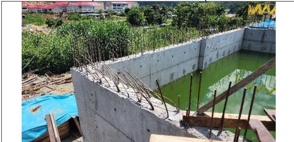
**Comentario:** acero de construcción con presencia de óxido (mechas para el techo) en el componente de tanque cisterna.
