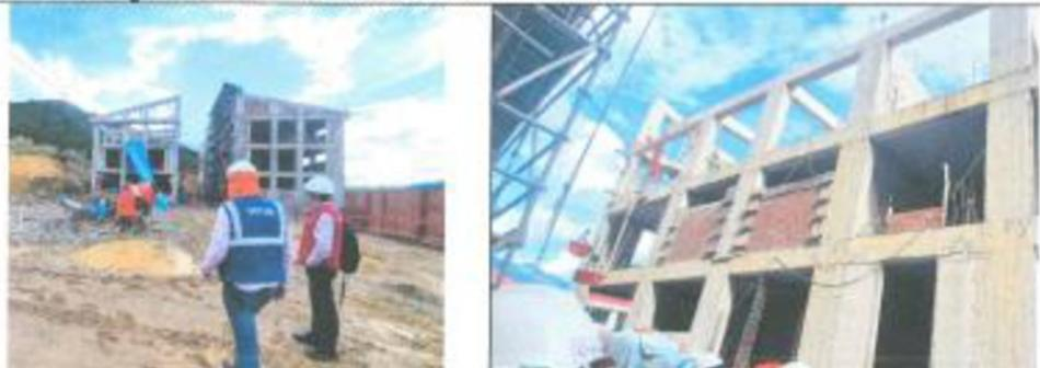
Comentario: Durante la inspección se verifica que se viene realizando trabajos de concreto en columnetas y viguetas, para lo cual se viene realizando el mezclado de concreto mediante una mezcladora tipo trompo y con material granular dispuesto al lado del equipo.
