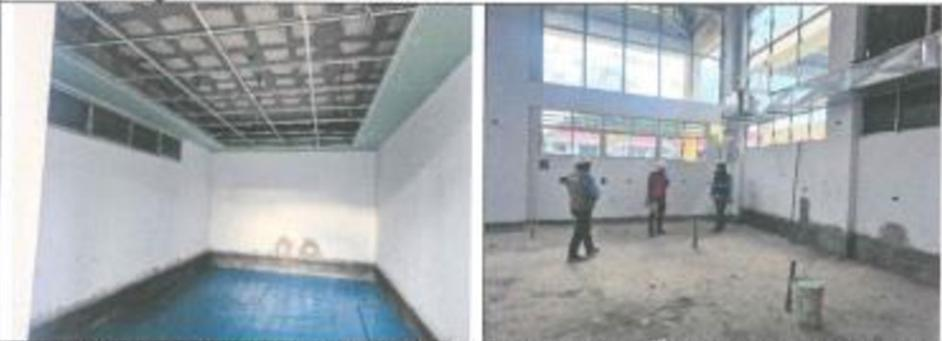
Comentario: Se verifica, que al interior de la infraestructura se ha realizado trabajos de drywall y perflería metálica para cielorraso, también trabajo de porcelanato en pisos; al igual que, colocación de ventanas
