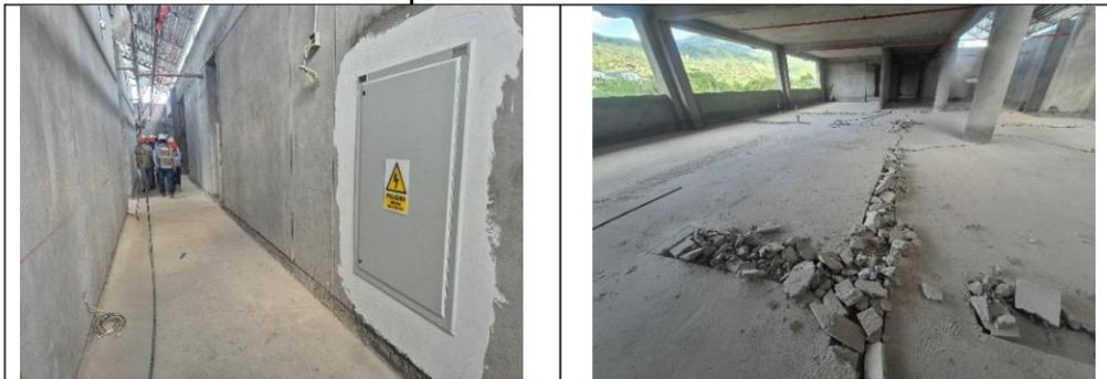
**Comentario:** Se constata trabajos de instalación de tablero y cableado eléctrico; así también, se observó cortes en falso piso de concreto.
