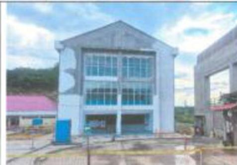
Comentario: Se constata el estado de la edificación, observando que se encuentra a nivel de pintura exterior, siendo que, en un lateral exterior no se realizaron dichos trabajos.
