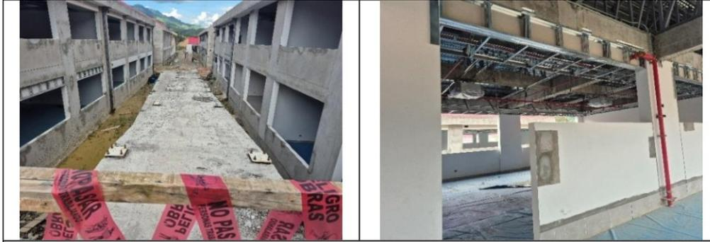
**Comentario:** Se viene realizando trabajos de movimiento de tierras en el primer piso del bloque, instalaciones mecánicas (sistema de aire acondicionado), trabajos de cielo raso con drywall y perfiles metálicos para baldosas.
