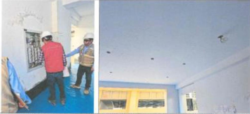
Comentario: En el interior del bloque, se constató la instalación del tablero eléctrico y el cableado en circuitos de luz y tomacorrientes.
