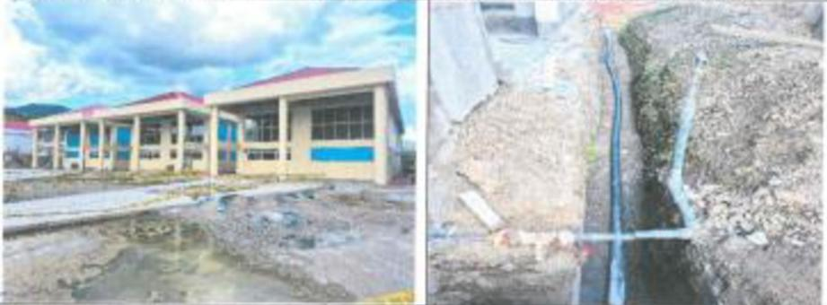
Comentario: La infraestructura de los laboratorios se encuentran a nivel de pintura exterior, siendo parte de la inspección el bloque IA-L3, donde se constató trabajos de tendido de tuberías HDPE, ubicados al lado izquierdo de la infraestructura.
