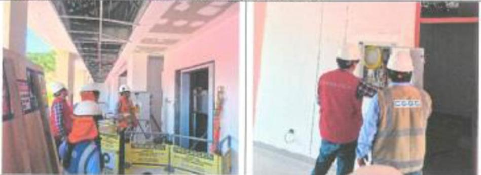
**Comentario:** En el tercer piso se viene realizando trabajos de instalación de ascensor; asimismo, se observa la instalación del tablero de control; también, se verifica trabajos de Drywall y perfiles metálicos para baldosas en cielorraso. Asimismo, en los trabajos del ascensor, se constata que para estos trabajos se coloca barrera metálica como protección de seguridad.
