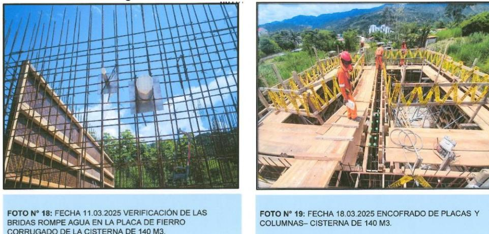
**FOTO N° 18:** FECHA 11.03.2025 VERIFICACIÓN DE LAS BRIDAS ROMPE AGUA EN LA PLACA DE FIERRO CORRUGADO DE LA CISTERNA DE 140 M3.
