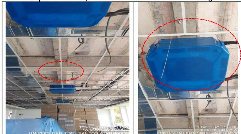
**Comentario:** En la infraestructura de Ing. Civil, se observa las unidades evaporadoras de 42,700 BTU/h instaladas por el personal del contratista el cual es parte de la partida de instalaciones HVAC. Ubicada en el tercer piso de la edificación.
