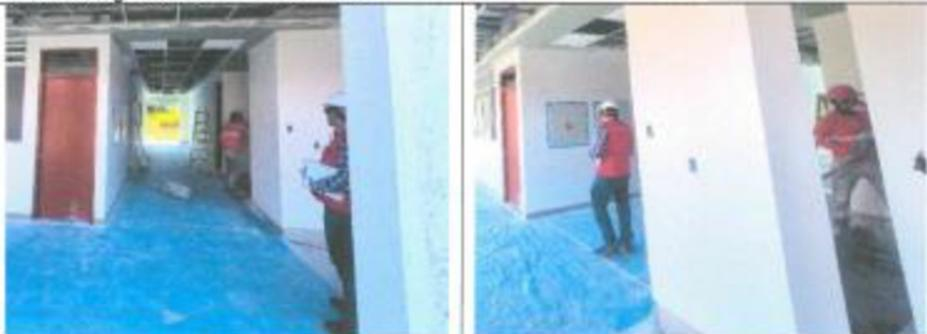
Comentario: Se verifica que, en el primer piso de la infraestructura de administración, se viene realizando el trabajo de lijado en muros interiores; asimismo, se observa trabajos de Drywall y estructura metálica en cielorraso.
