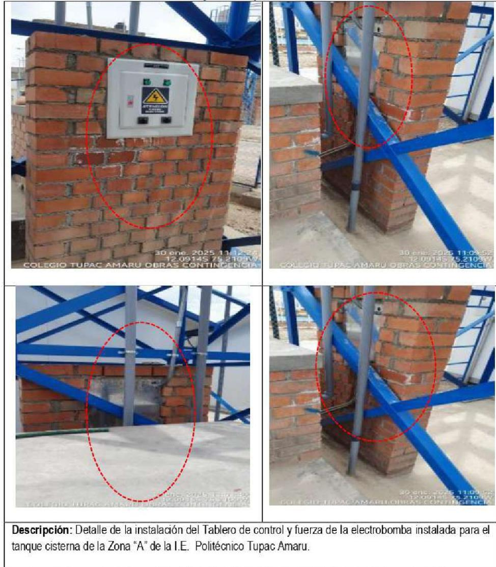
**Descripción:** Detalle de la instalación del Tablero de control y fuerza de la electrobomba instalada para el tanque cisterna de la Zona "A" de la I.E. Politécnico Tupac Amaru.
