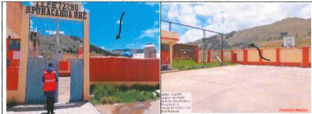
Cerco perimétrico en mal estado, y 100 metros lineales sin cerco perimétrico
