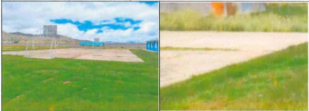
La única losa deportiva requiere sustitución, ya que se visualiza fisuras considerables en las cuales se aprecia el brote de maleza verdosa.
