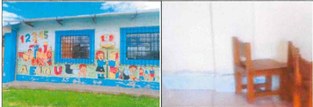
Las paredes de las aulas requieren mantenimiento tanto interiormente y exteriormente debido a las filtraciones de humedad y agua.
