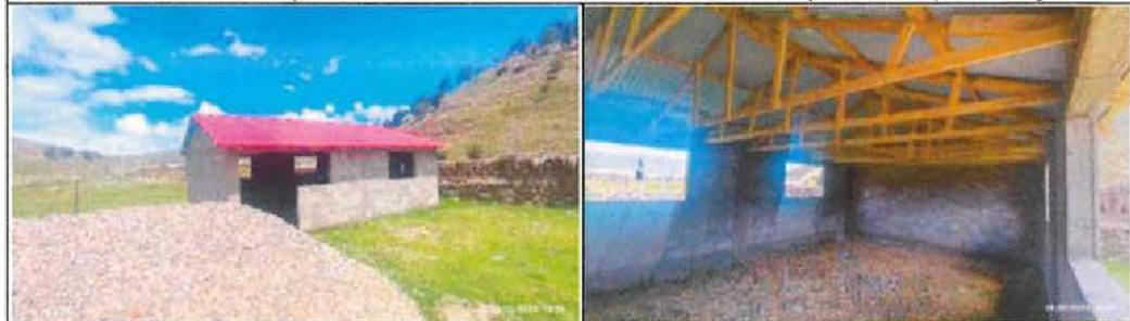
Las paredes de bloqueta, aún no tienen acabados interiores ni exteriores.
