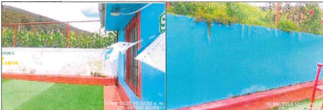
Se evidenció que el cerco perimétrico tiene erosiones y rajaduras.
