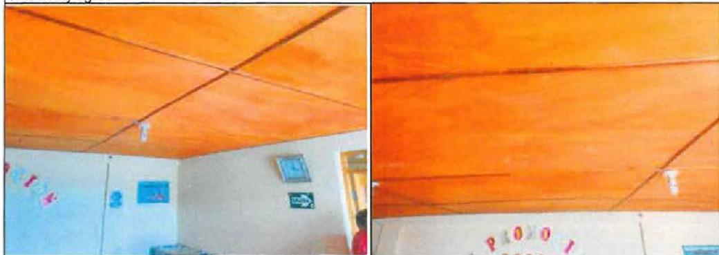
Los techos de las aulas requieren mantenimiento debido a que en épocas de lluvia se presenta filtraciones en distintos sectores de los techos.
