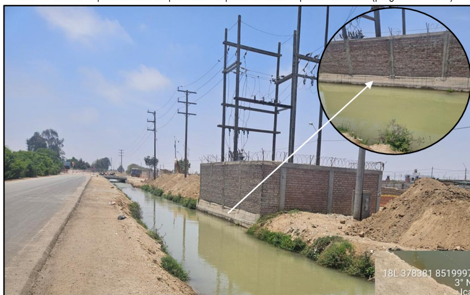
Imagen N° 5 Uno de los muros perimetrales del predio forma parte del talud izquierdo del canal (progresiva 4+520)
