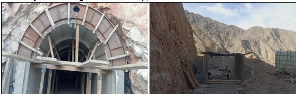
Imagen n.º 7 Túnel N.º 3 y canal rectangular con wáter stop, sin estructura de unión entre ambos elementos.
