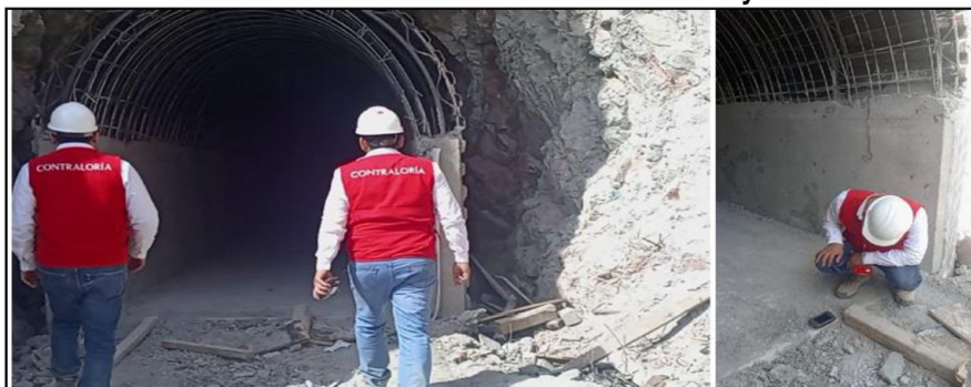
Imagen n.º 5 Ausencia de estructura de unión entre túnel n.º 3 y canal
