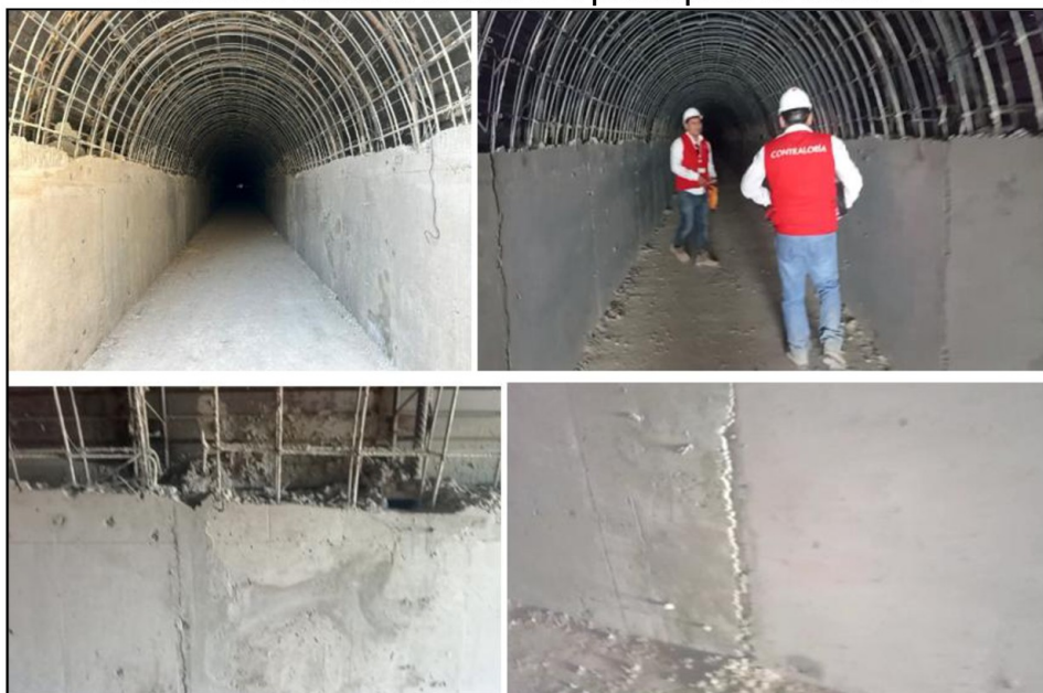
Imagen n.º 6 Ausencia de vaciado de concreto en la parte superior del túnel N.º 3
